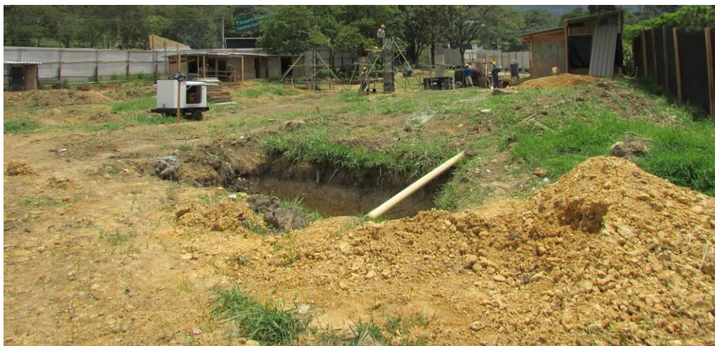
Fotografía 3.6. Zonas intervenidas. Potencial Bajo
