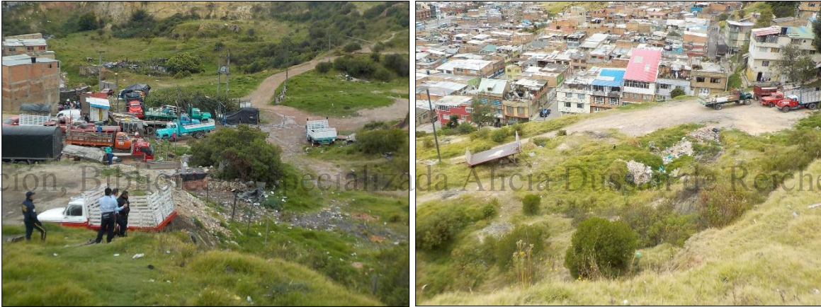
Fotografía 4-5 Intervenciones por adecuación de parqueadero y talleres dentro del polígono.
