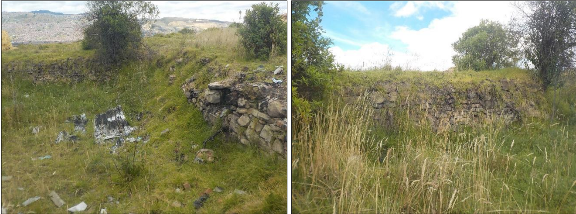
Fotografía 4-4 Estructuras en piedra asociadas a la dinámica de producción ladrillera hallada dentro del polígono.
