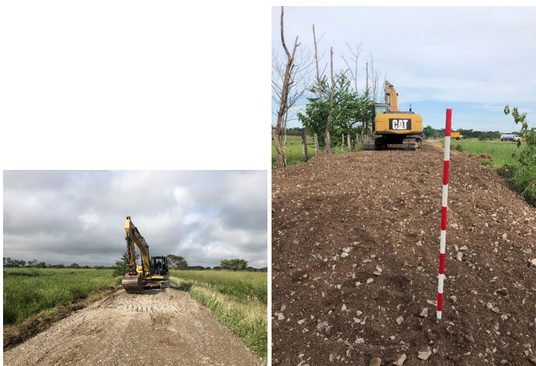
Figura 17. Seguimiento en monitoreo a la construcción de la vía
