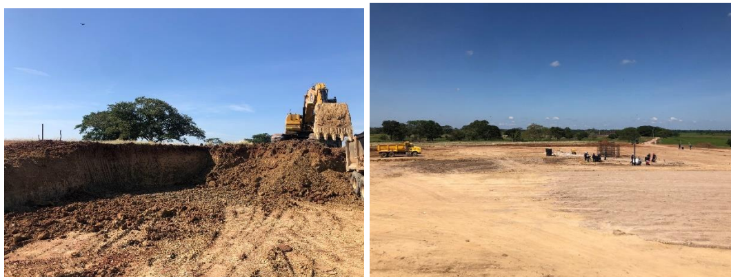
Figura 18. Seguimiento en monitoreo a la construcción de la vía
