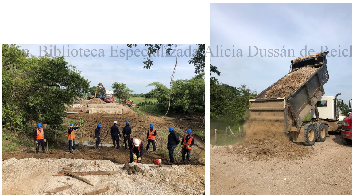
Figura 14. Seguimiento en monitoreo a la construcción del puente
