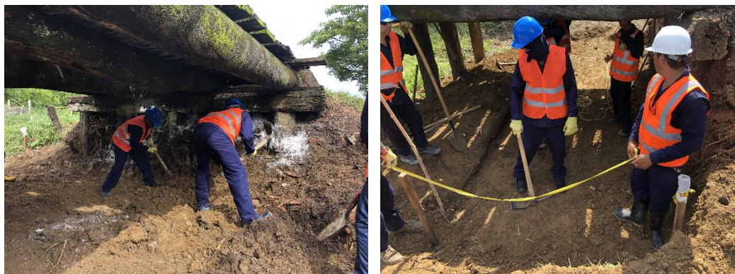
Figura 12. Seguimiento en monitoreo a la construcción del puente
