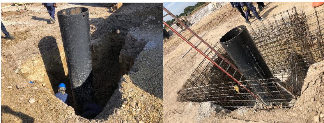
Figura 19. Seguimiento en monitoreo a la construcción de los contrapozos
