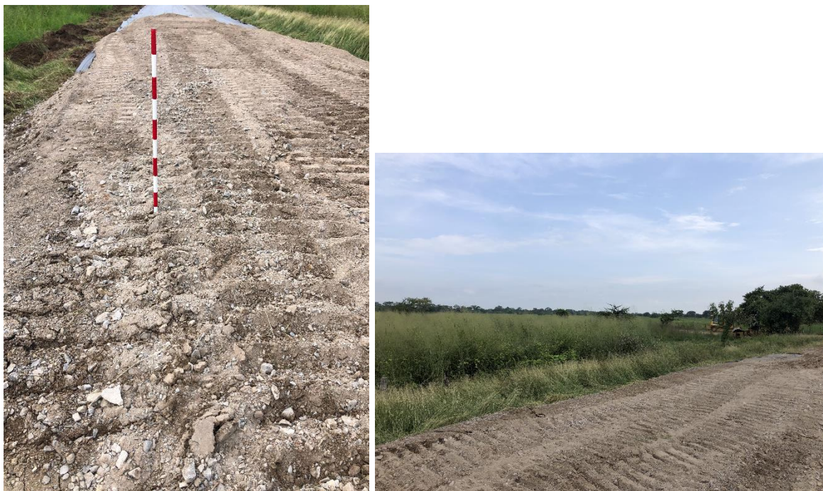
Figura 16. Seguimiento en monitoreo a la construcción de la vía
