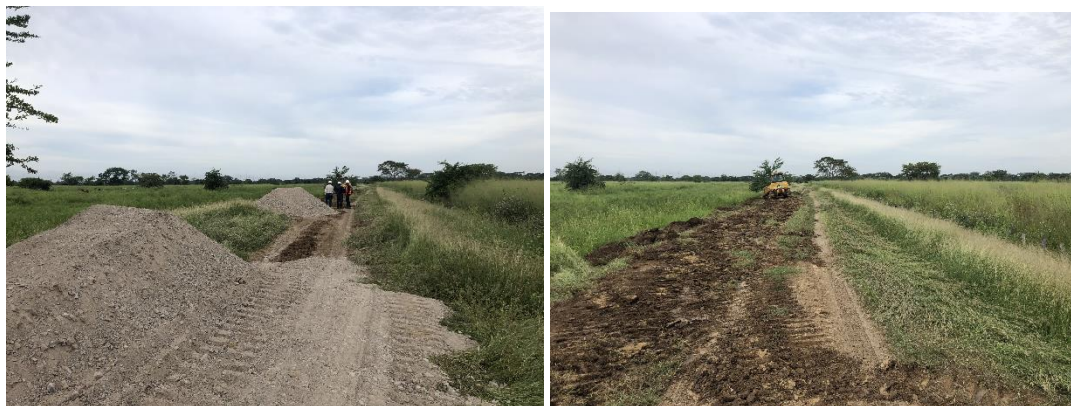
Figura 15. Seguimiento en monitoreo a la construcción de la vía
