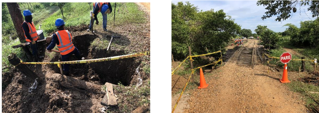
Figura 13. Seguimiento en monitoreo a la construcción del puente
