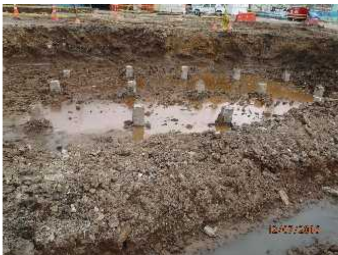
Foto 115. Excavación K1 +790, puente abscisa derecha
