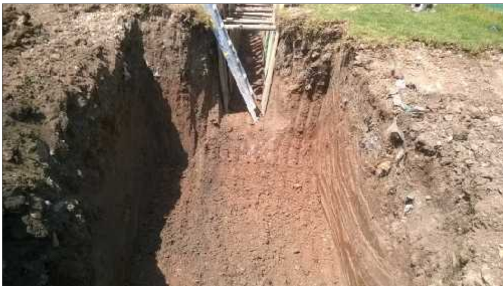
Foto 30. Excavación para pozo de red de tuberías Calle 73d sur
