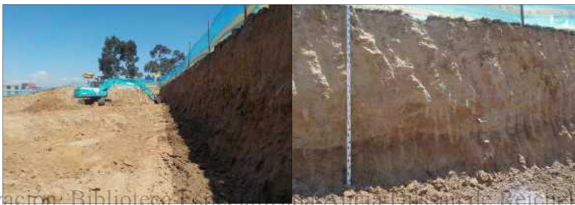
Foto 37. Descapote y excavación para pilotaje
