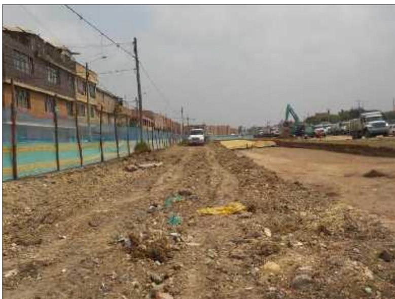
Foto 36. Descapote para espacio público K0+090 y K0+270 costado derecho
