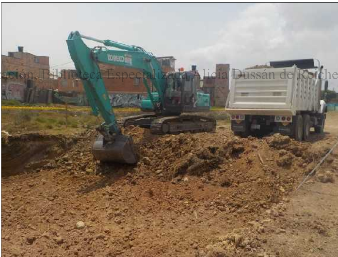
Foto 5 – Excavación para cajeo de la vía, perfil.
