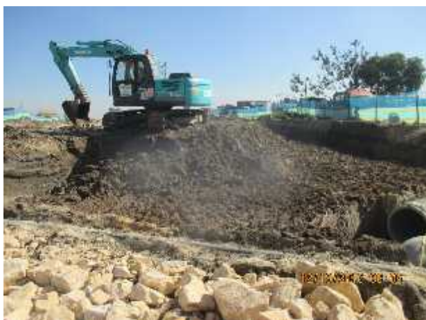
Foto 102. Proceso de excavación mecánica K1+200 costado derecho.
