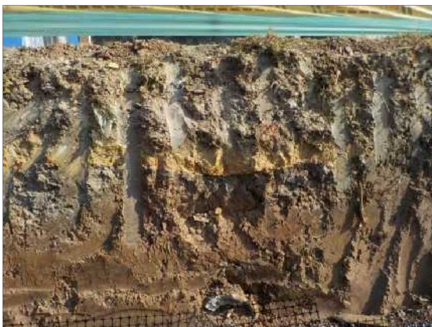
Foto 10. Perfil expuesto, excavación de calzada carril izquierdo, K0+620-K0+780
