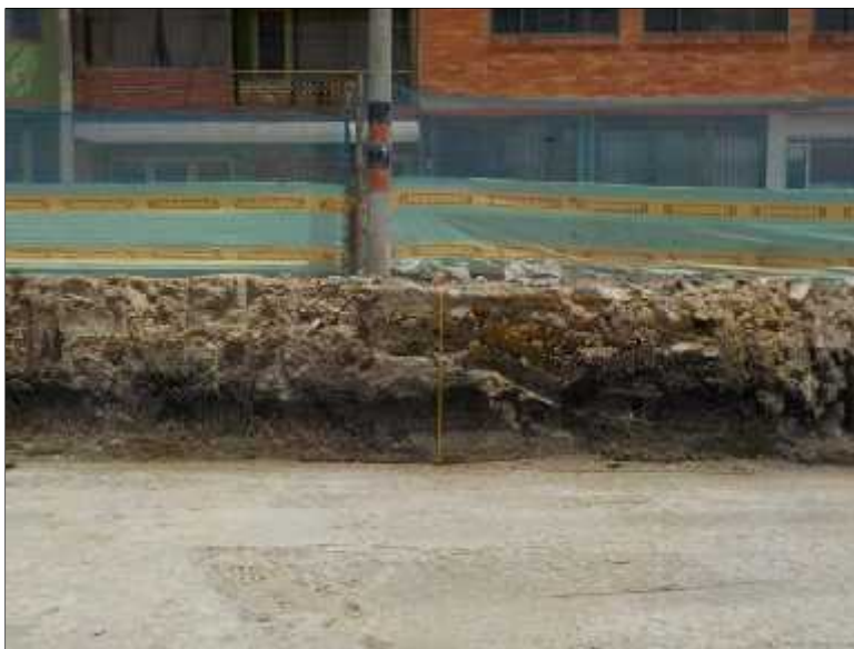
Foto 21. Perfil de excavación K1+000 –K1+065. Resultado negativo
