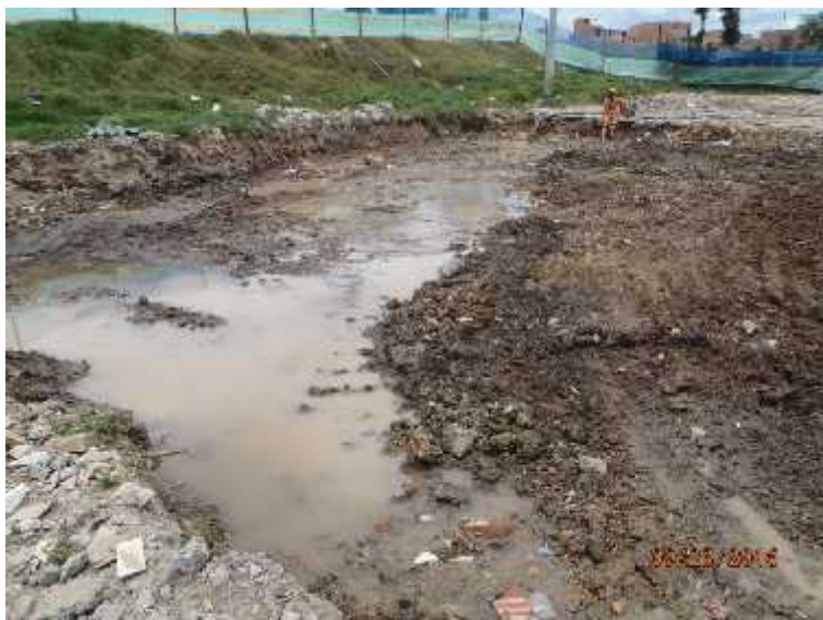
Foto 92. Proceso de excavación abscisa K1+700 calzada izquierda.
