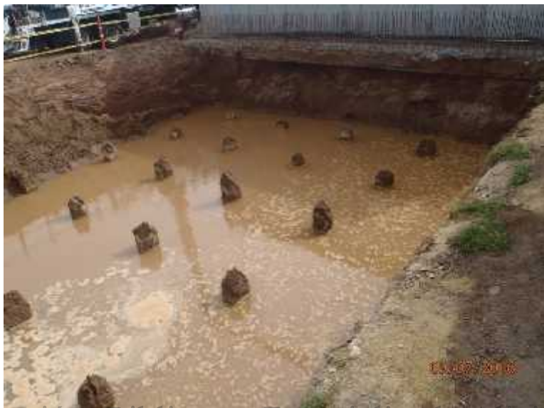
Foto 91. Excavación K1+605 abscisa derecha
