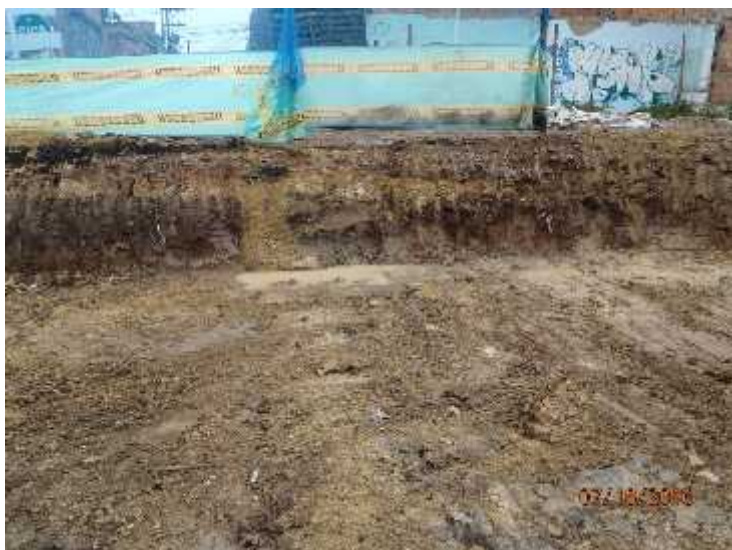
Foto 81. Proceso de excavación, K0+730 abscisa derecha
