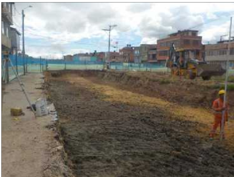
Foto 60. Excavación de vía entre el K1+080 y K1+170
