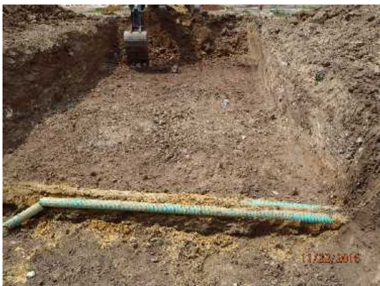
Foto 113. Excavación mecánica K0+ 420, separador.
