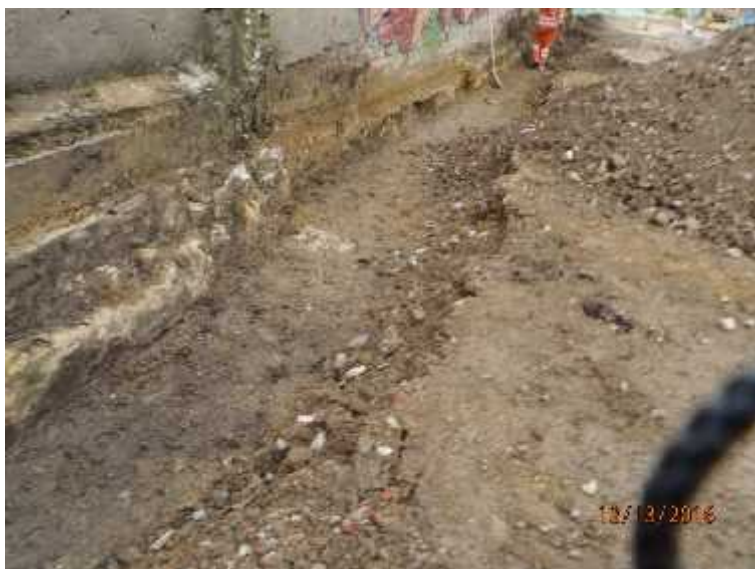
Foto 112. Excavación K0+920, abscisa derecha.
