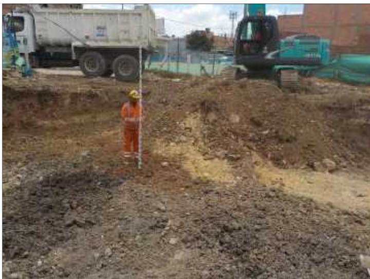
Foto 18. Excavación cajeo de vía K0+900 hasta el K1+030
