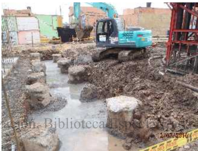
Foto 114. Inicio Proceso de excavación K1+730, abscisa izquierda.
