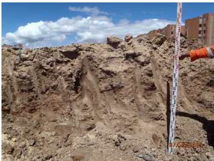
Foto 82. Proceso de excavación, K0+448
