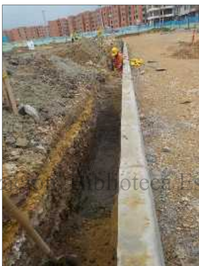
Foto 61. Excavación para filtros longitudinales
