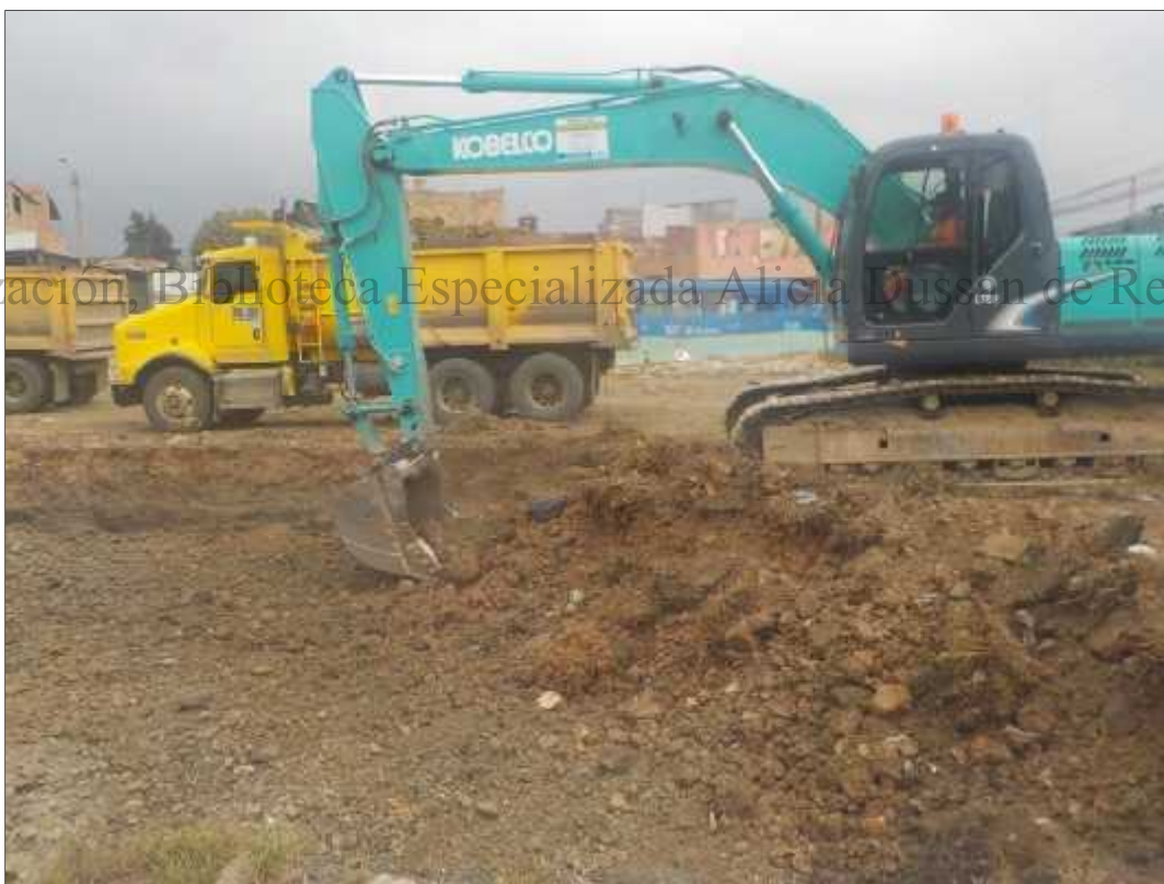
Foto 47. Proceso de excavación de vías en el K0+080
