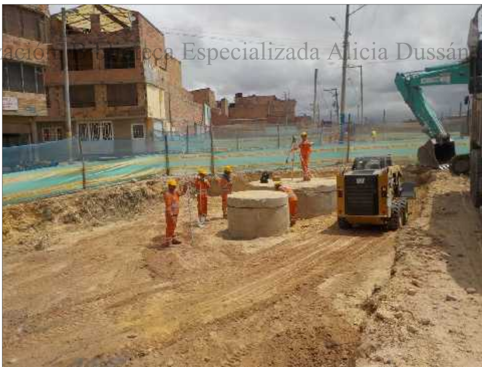
Foto 14. Excavación, estructura de ducto expuesta.
