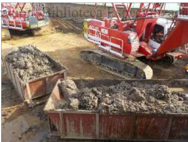
Foto 42. Proceso de deposición del material extraído
