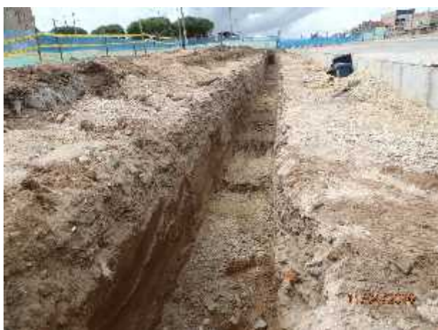
Foto 103. Proceso de excavación K0+340 costado derecho.
