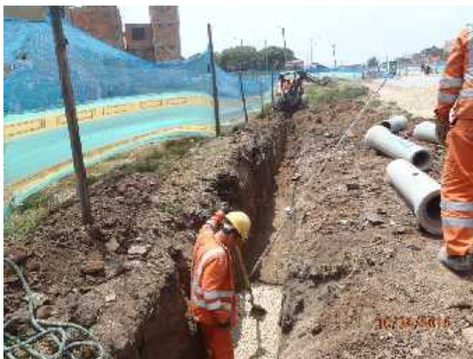
Foto 107. Proceso de excavación mecánica incorporación de redes K0+300, abscisa derecha.
