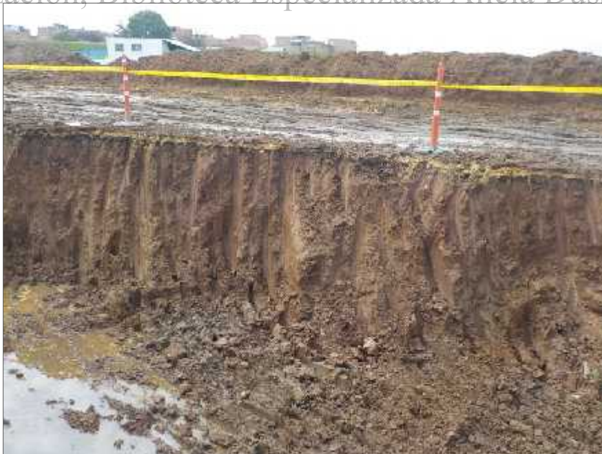
Foto 72. Perfil de la excavación cerca al río Tunjuelito. Profundidad 2,70 ms
