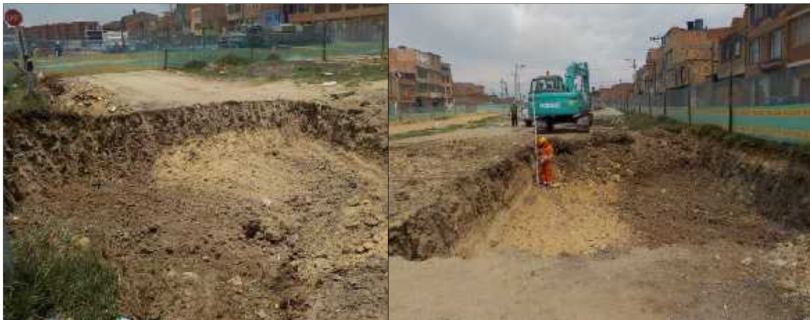
Foto 16. Excavación para cajeo de vía K0+796 y K0+860
