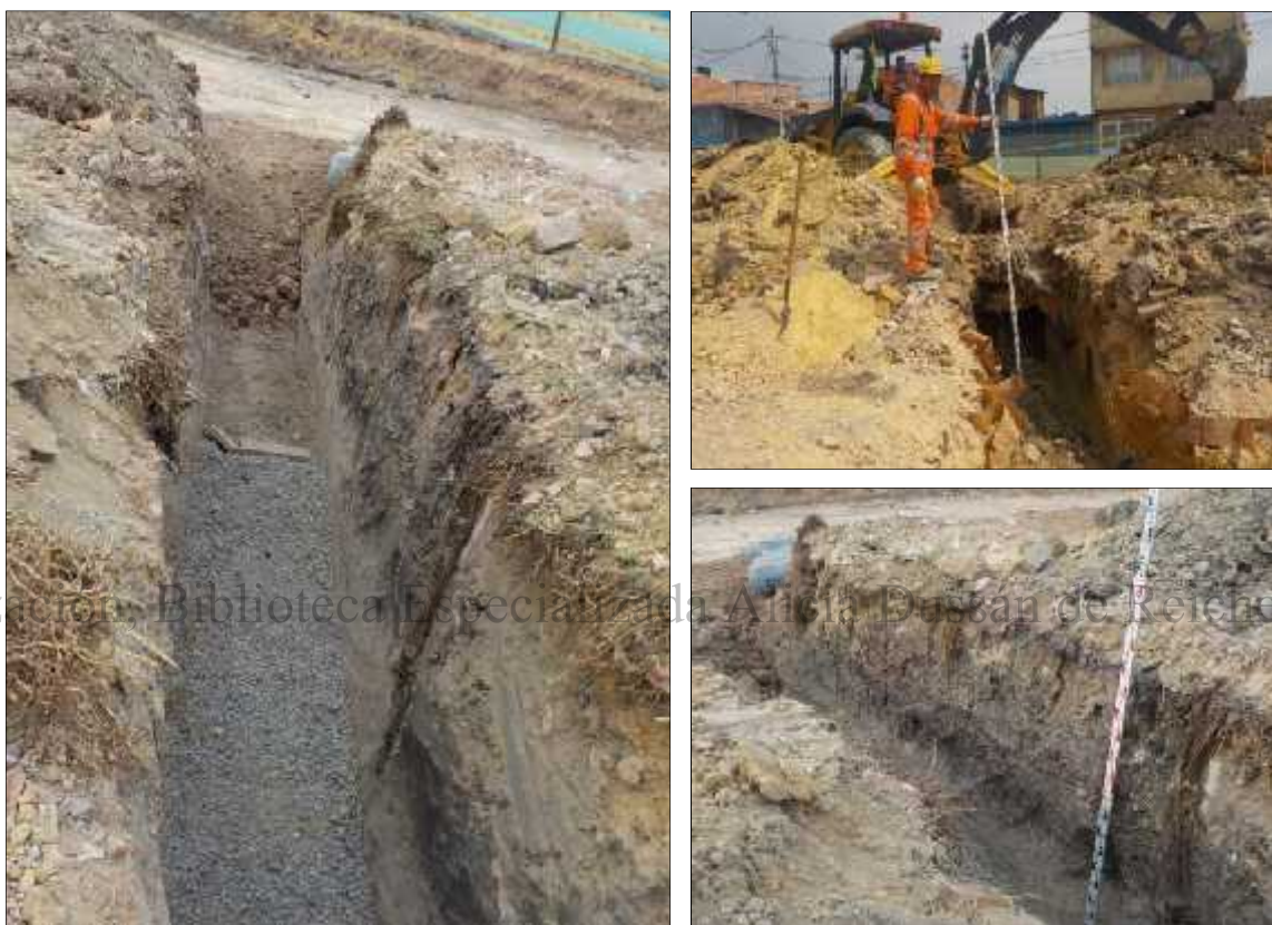
Foto 34. Excavación para instalación de redes K1+085, costado izquierdo.
