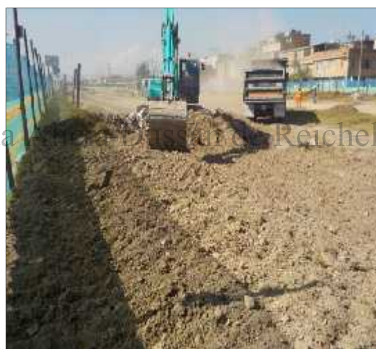
Foto 4 – Proceso de excavación en K0+090 – K0+270, perfil expuesto 65 cms.
