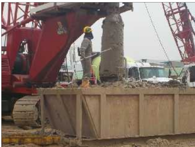
Foto 41. Excavación e inyección de polímero
