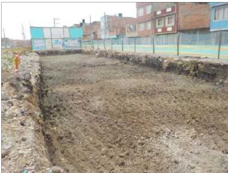
Foto 20. Excavación cajeo de vía, carril izquierdo K1+000 – K1+065
