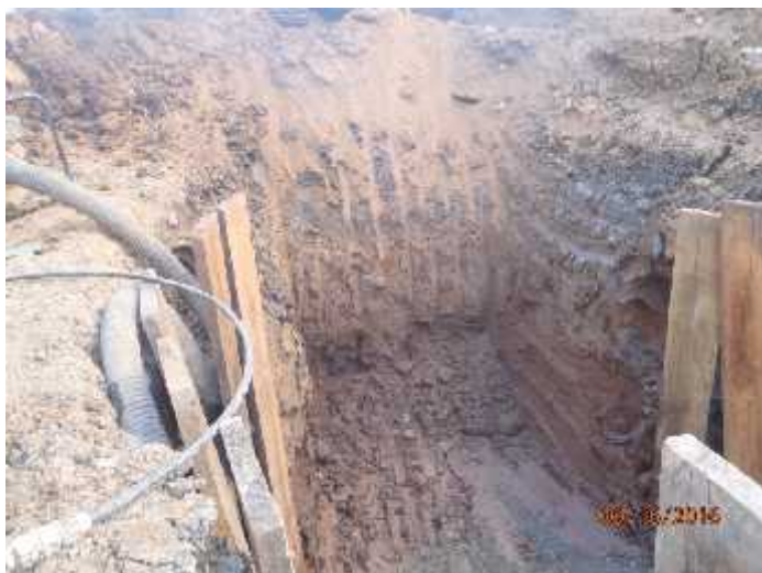
Foto 83. Proceso de excavación, cale 73D sur, K0+020.
