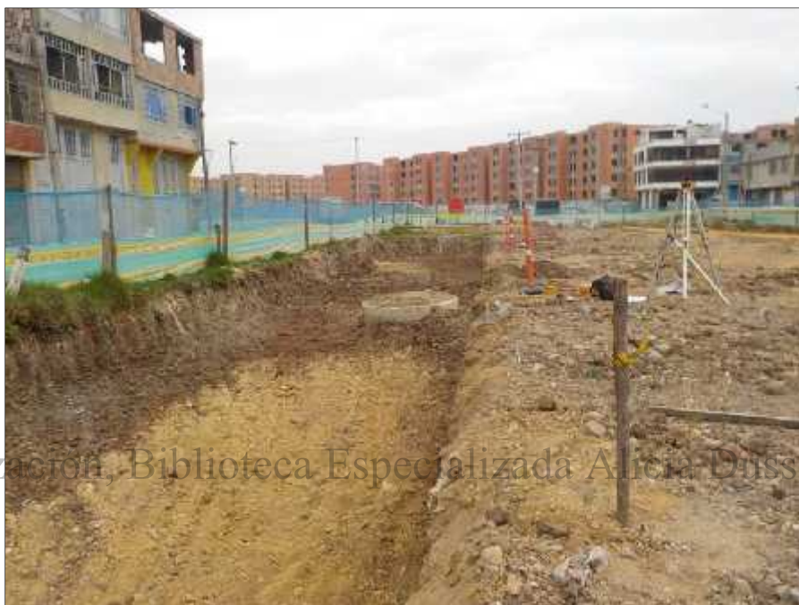
Foto 7. Excavación para cajeo de vía K0+620 y K0+780, tapa de alcantarillado expuesta
