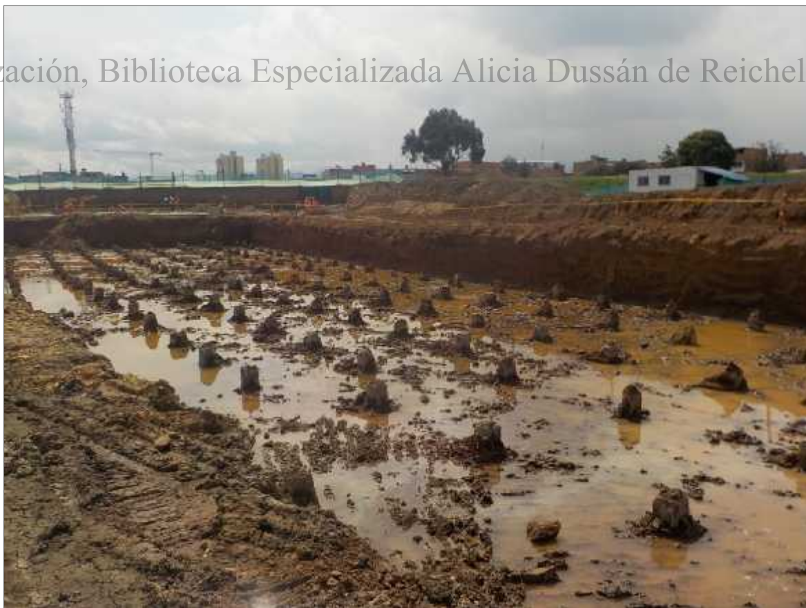
Foto 70. Área excavada cerca al río Tunjuelito
