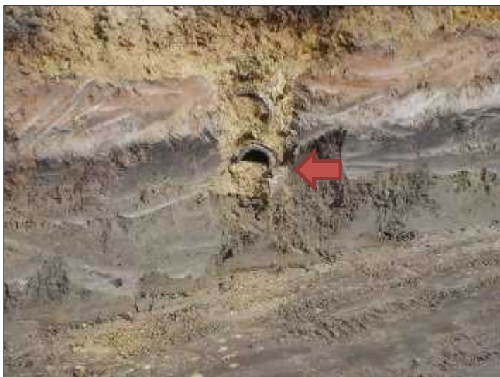
Foto 50. Exposición en perfil de excavación tubería sin uso en el K0+430
