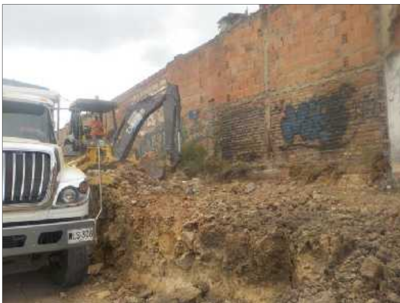
Foto 35. Excavación de espacio público K1+900.
