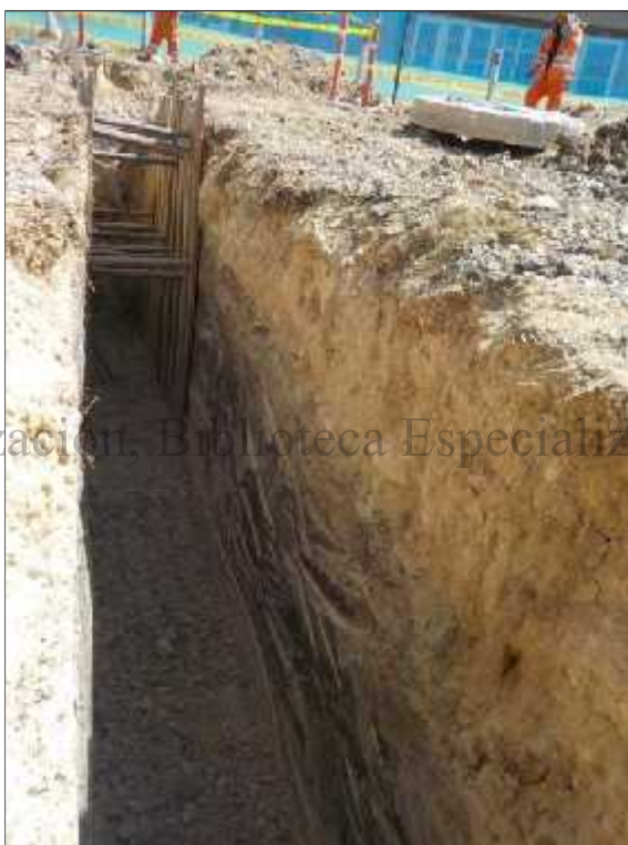
Foto 31. Excavación instalación de tubería K0+835.
