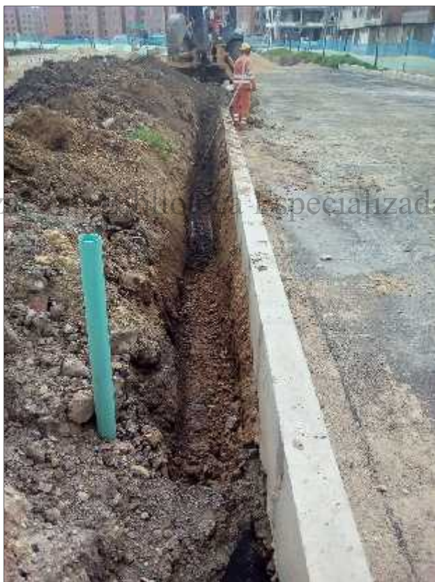
Foto 63. Excavación de filtro longitudinal en el K0+680
