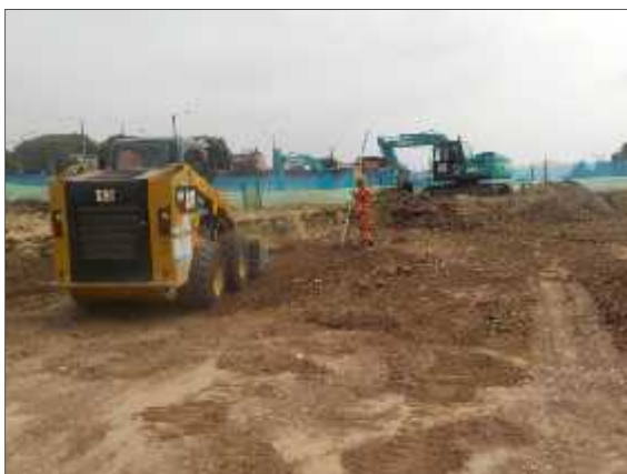
Foto 6. Excavación para cajeo de vía, calzada izquierda K0+280 y K0+400
