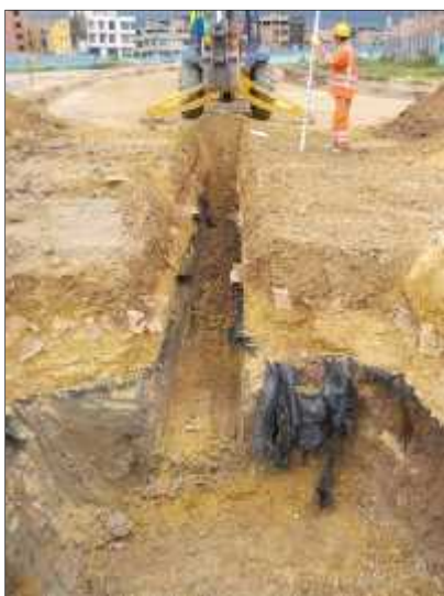
Foto 62. Excavación para instalación de redes K0+470
