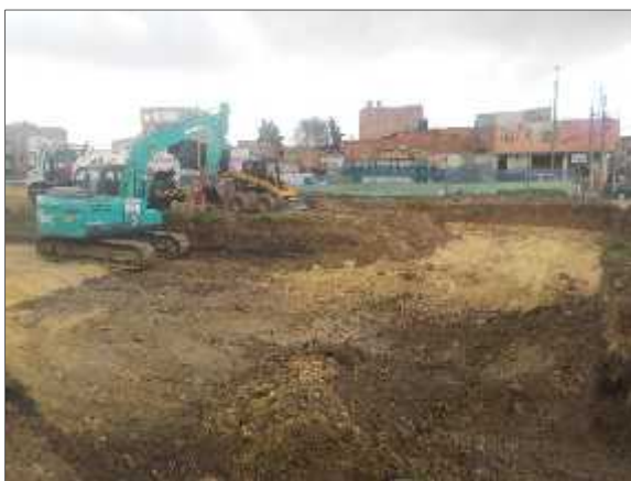
Foto 45. Excavación de vía en el K0+000. Inicio del proyecto, avenida San Bernardino
