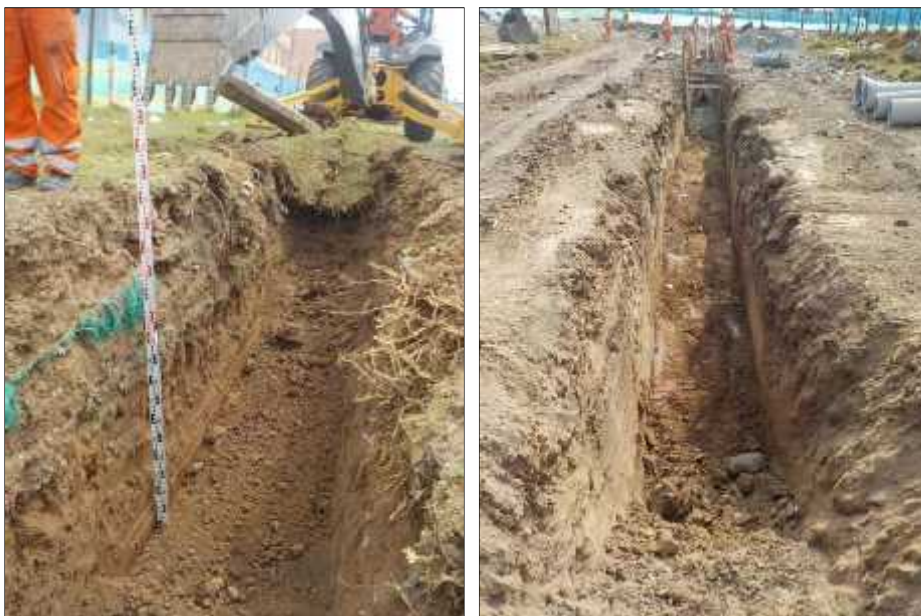
Foto 27. Perfil expuesto, y extensión de excavación red de tuberías. Calle 72 sur
