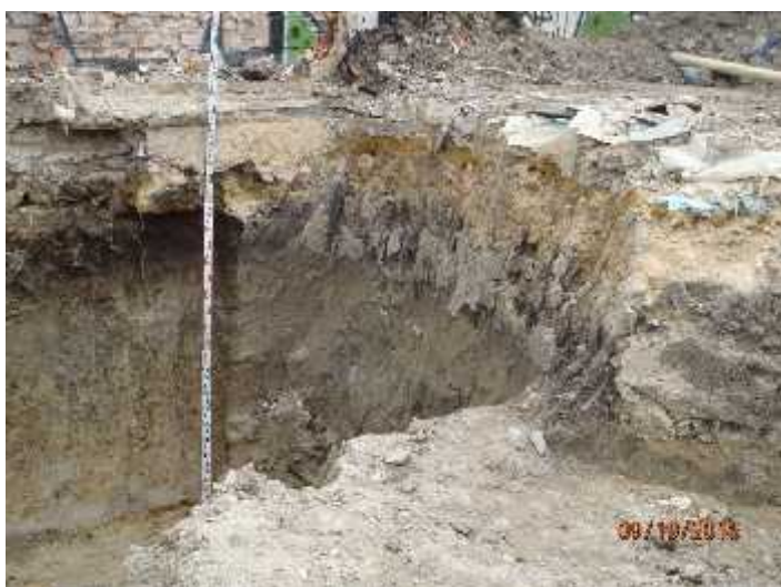
Foto 84. Proceso de excavación, espacio público K0+010 abscisa derecha.
