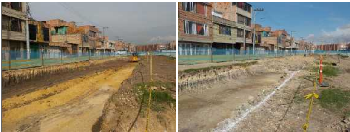
Foto 59. Excavación para cajeo de vías entre el K0+770 y K0+860
