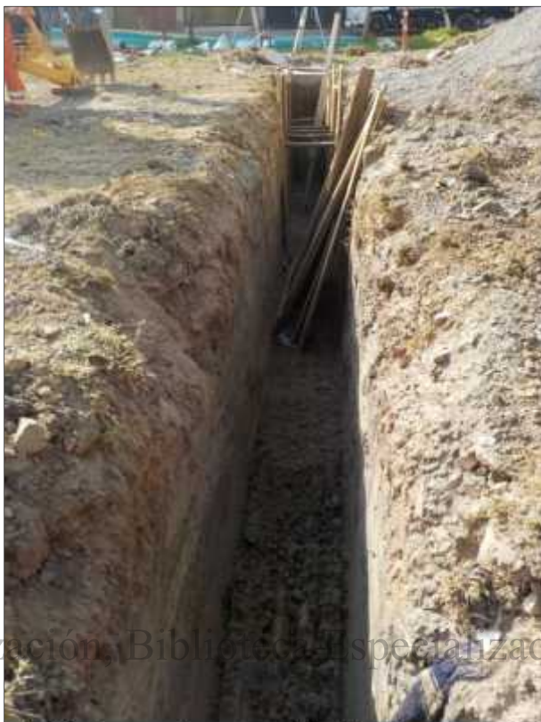
Foto 29. Excavación para red de tuberías segmento 3 (calle 73d sur)
