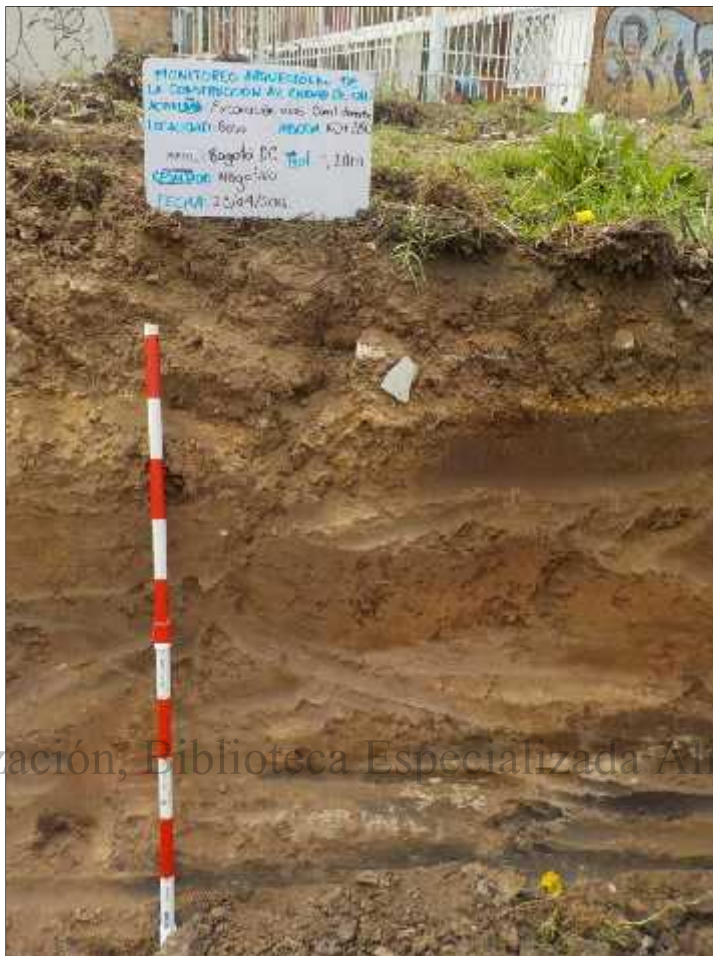
Foto 48. Perfil del suelo K0+380, calzada derecha
