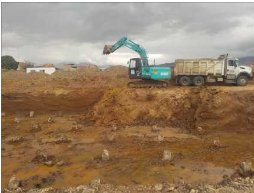
Foto 71. Proceso de excavación entre el K1+550 y K1+610
