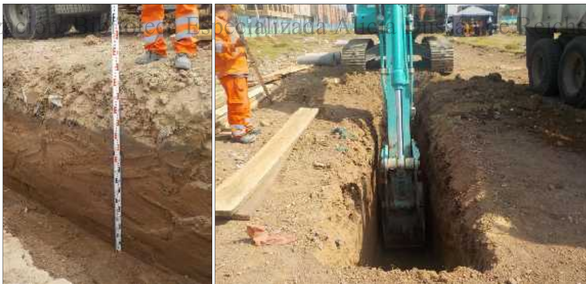
Foto 26. Excavación red de tuberías Calle 72 sur
