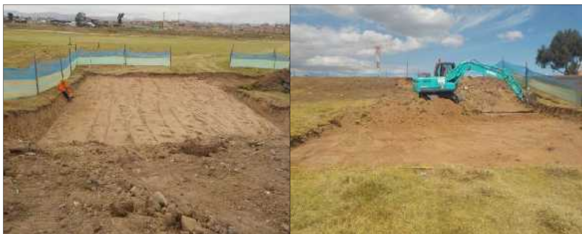
Foto 38. Excavación para pilotaje y perfil de suelo. Resultado negativo
