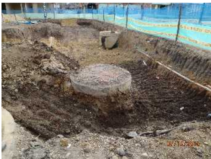
Foto 80. Proceso de excavación, K0+790
