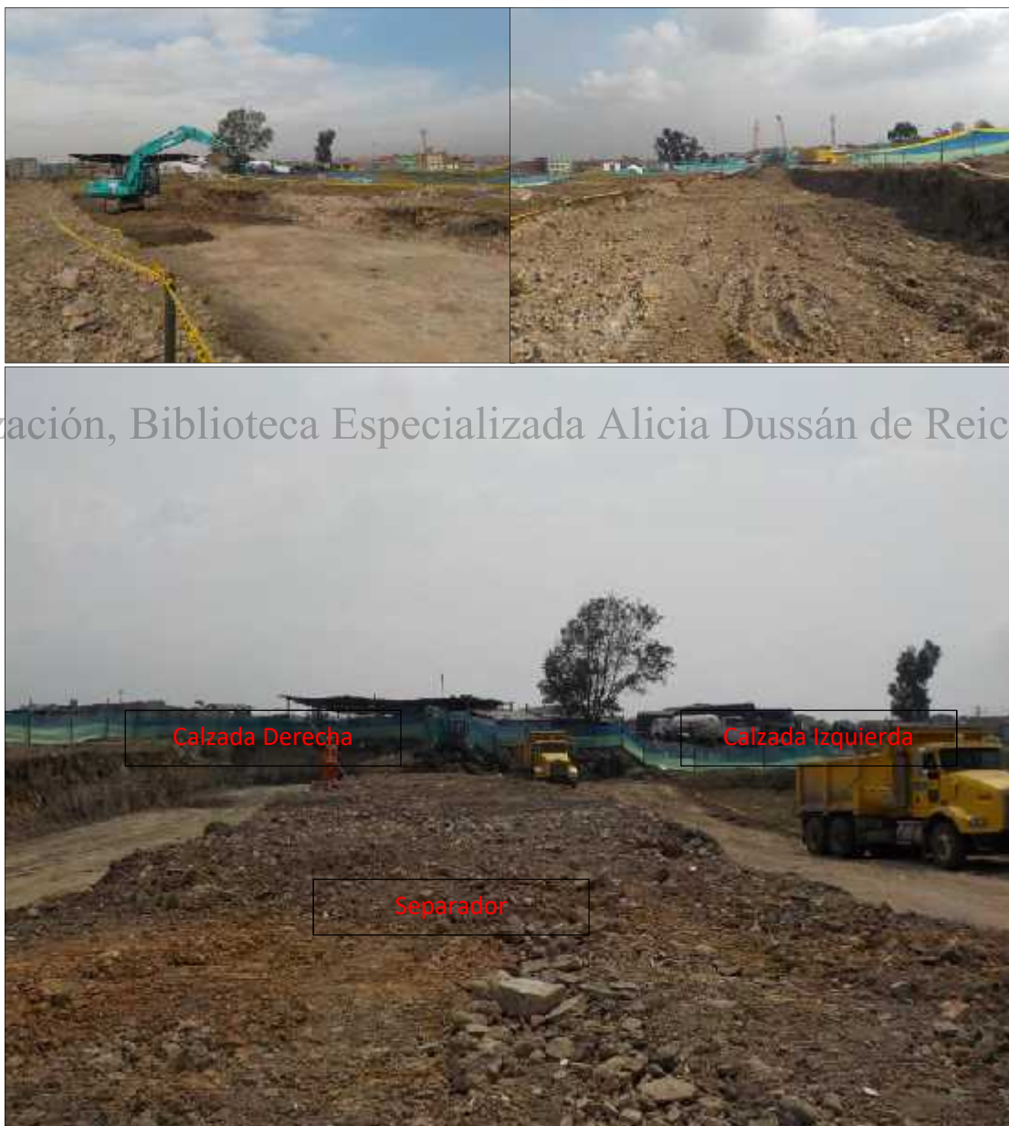
Foto 25. Descapote de separador y excavación para cajeo de vía en el K1+380 y K1+450
