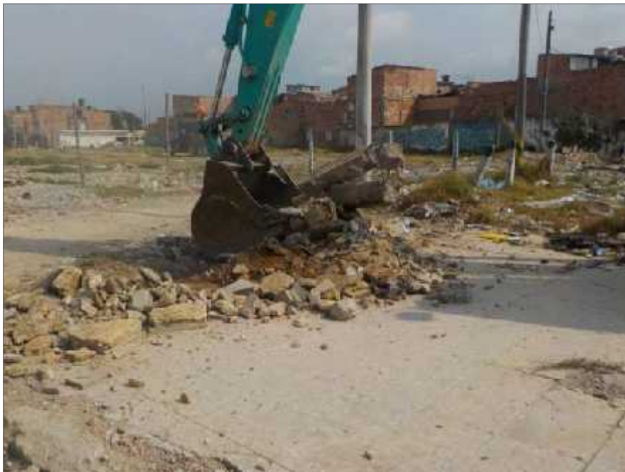
Foto 2 – Inicio de excavación para extracción de base
