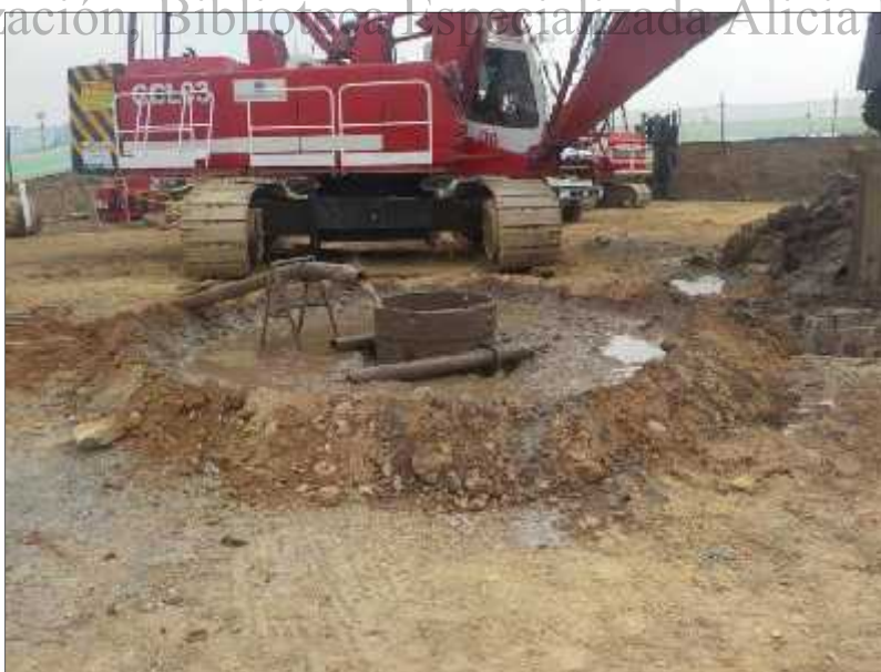
Foto 40. Zona cerca al río Tunjuelito después de la excavación
