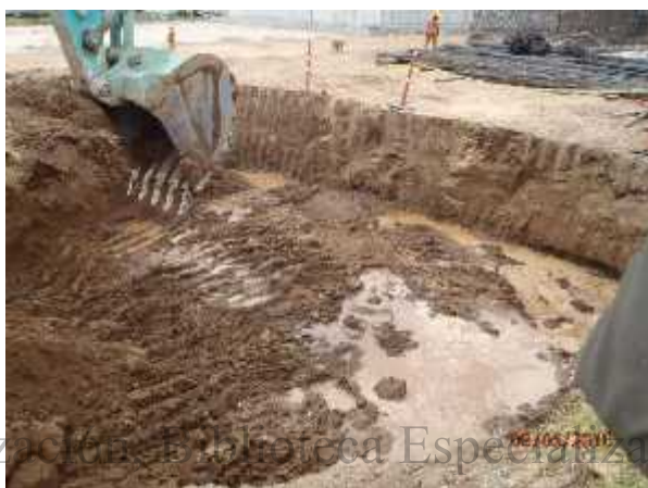
Foto 89. Inicio Proceso de excavación, K1+600 abscisa derecha
