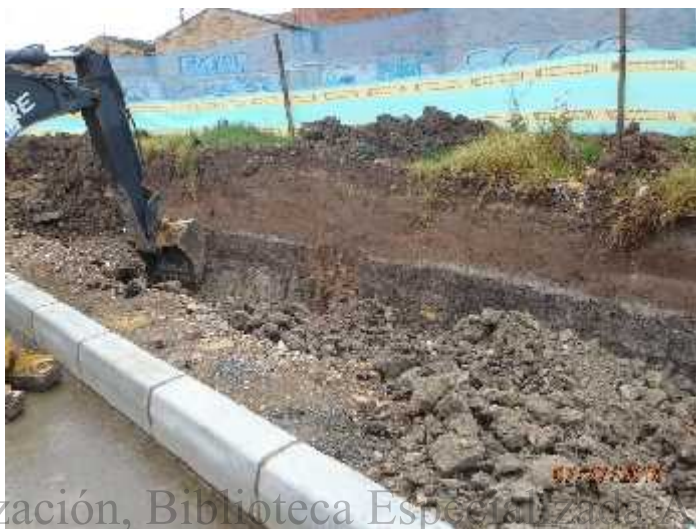
Foto 85. Proceso de excavación, K0+440 abscisa derecha
