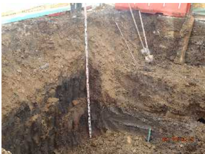
Foto 79. Proceso de excavación cale 73d sur k0+007.
