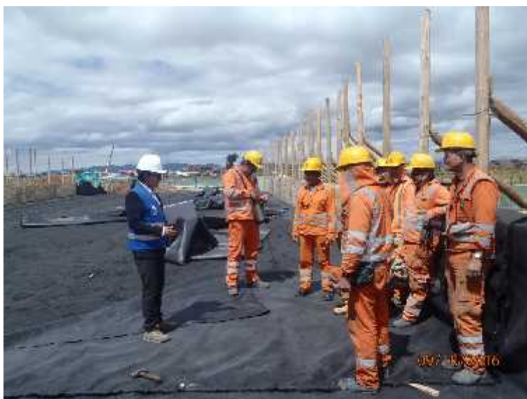
Foto 96. Charla informativa construcción puente.
