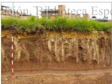
Foto 55. Perfil de excavación en el K0+520 carril izquierdo, costado izquierdo.
