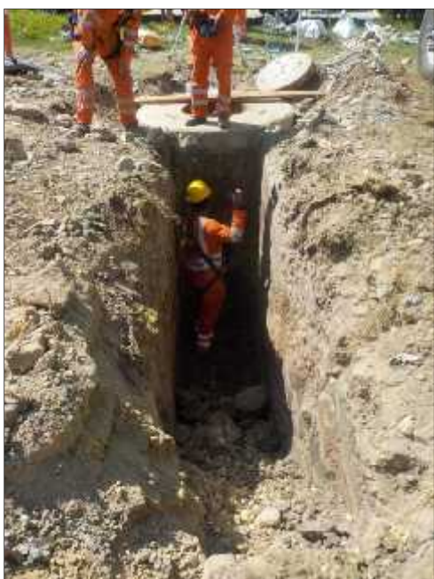
Foto 28. Perfil de excavación para redes de tubería Calle 73d sur
