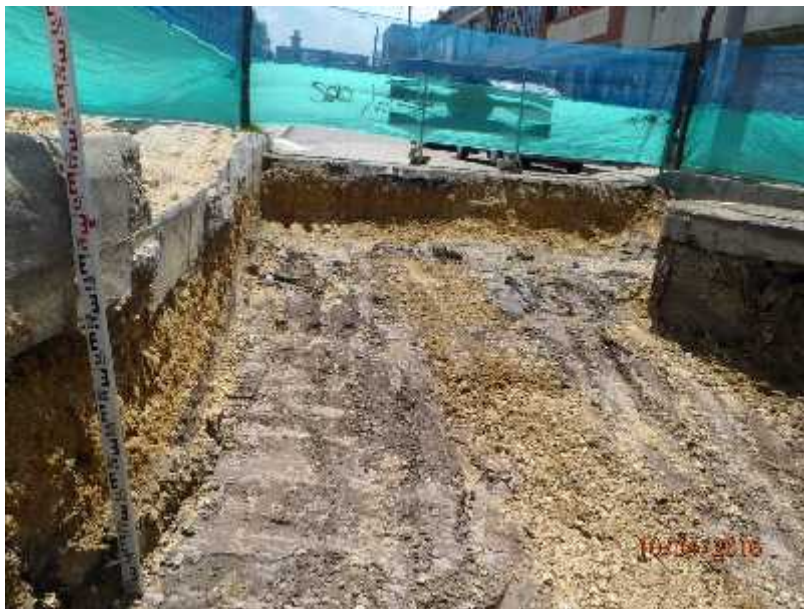
Foto 101. Proceso de excavación calle 75 con carrera 80 P sur, costado derecho.
