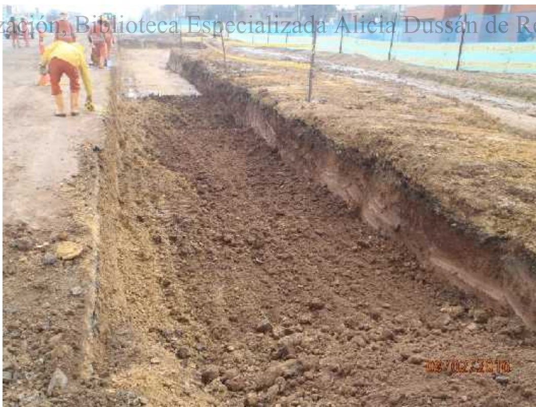
Foto 76. Excavación K0 +400 AL k0+490, calzada de servicio abscisa izquierda.
