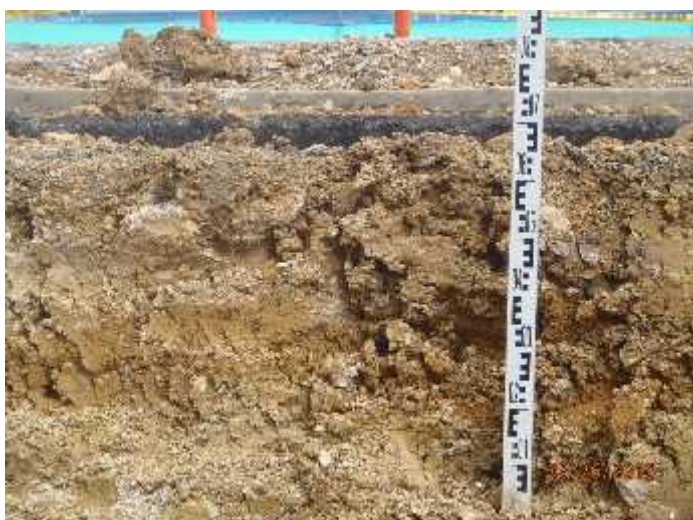
Foto 87. Excavación en K0 +080, calzada de servicio abscisa derecha.
