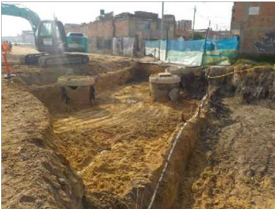
Foto 15. Excavación para cajeo de vía K0+865 carril derecho, presencia de redes de alcantarillado y gasoducto
