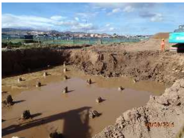
Foto 90. Excavación K1 +560 puente abscisa derecha
