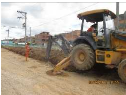
Foto 65. Excavación de filtros longitudinales en el K0 +740 al K0+770. No se encontró material arqueológico.
