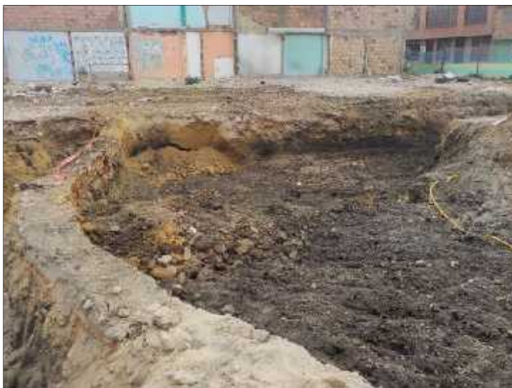
Foto 17. Excavación para cajeo de vía K0+865 carril izquierdo, presencia de redes de alcantarillado y gasoducto
