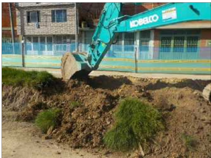
Foto 58. Proceso de excavación entre el K0+650 y K0+740
