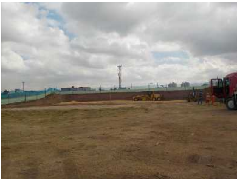
Foto 39. Excavación para pilotaje y perfil de suelo. Resultado negativo
