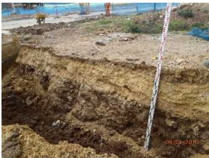
Foto 88. Proceso de excavación, K0+100 abscisa izquierda
