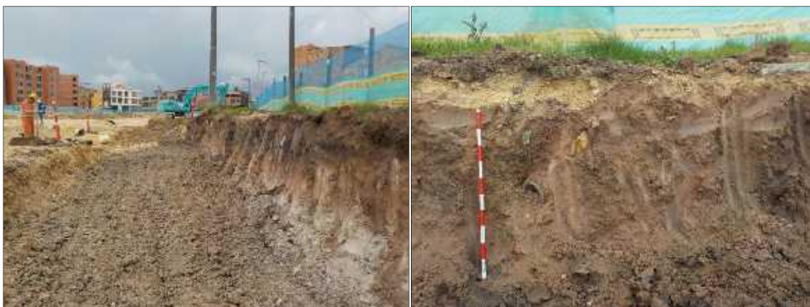
Foto 68. Proceso de excavación y perfil de excavación entre el K0+450 y K0+520
