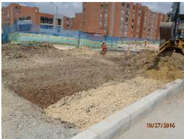
Foto 109. Proceso de excavación espacio público K0+270 AL K0+280.
