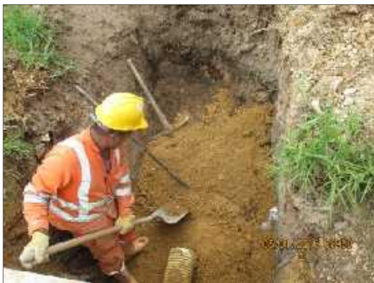
Foto 64. Excavación para caja de alcantarilla en el K0+740
