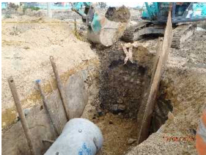
Foto 105. Proceso de excavación K1+180 abscisa derecha.
