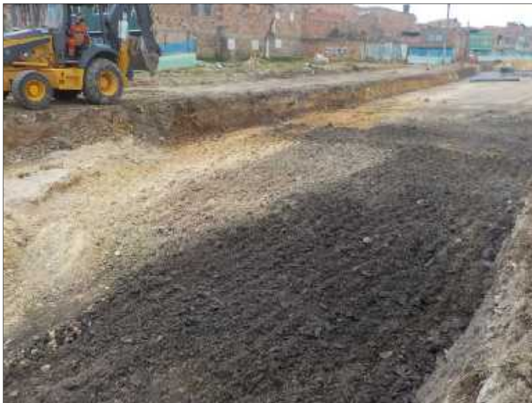
Foto 19. Mezcla de suelos, excavación cajeo de vía, carril derecho K0+900 hasta el K1+030
