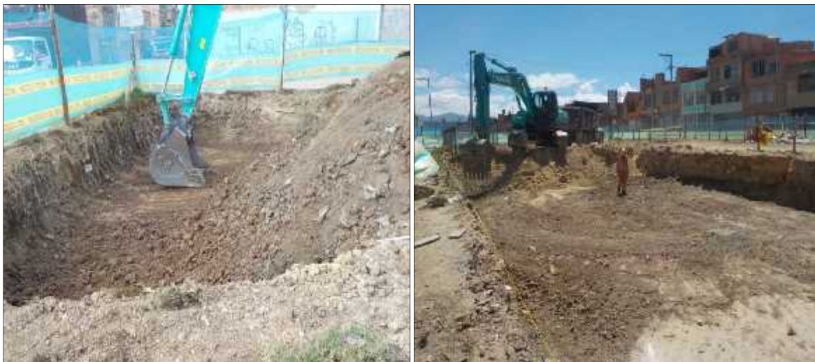
Foto 13. Excavación de vías K0+796-K0+860. Resultado negativo
