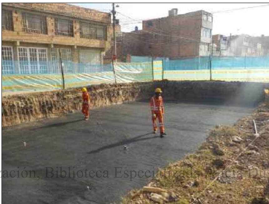
Foto 9. Excavación carril izquierdo para cajeo de vía K0+620 y K0+780
