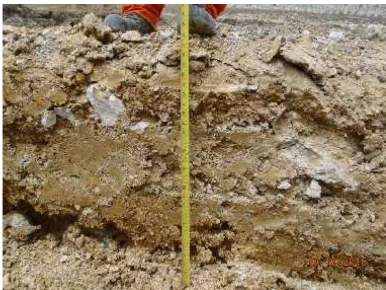
Foto 111. Proceso de excavación vía de servicio K0+055, calzada derecha.
