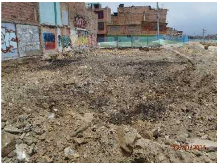
Foto 110. Excavación espacio público, K0+880 al K0+930, abscisa izquierda.
