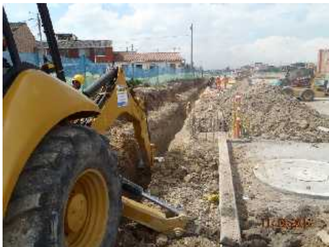
Foto 108. Excavación instalación redes K0+480 abscisa derecha.
