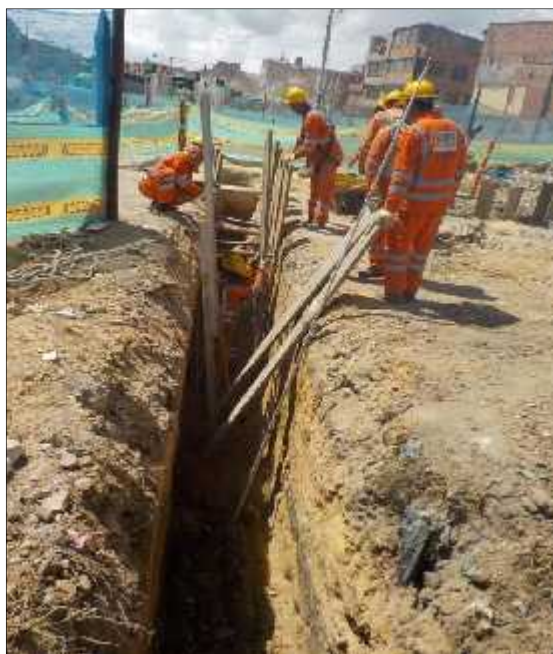
Foto 32. Excavación para red de tuberías, K0+896. Resultado negativo
