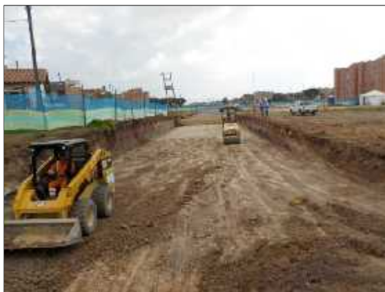
Foto 49. Excavación de vías entre el K0+410 y K0+500
