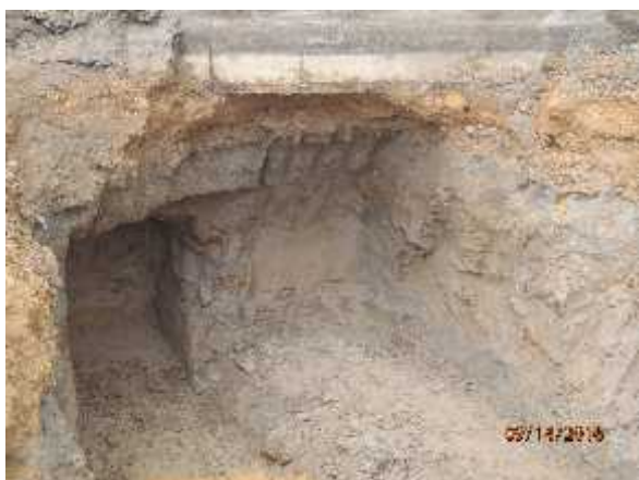
Foto 78. Excavación K0 +007, calzada de servicio abscisa derecha
