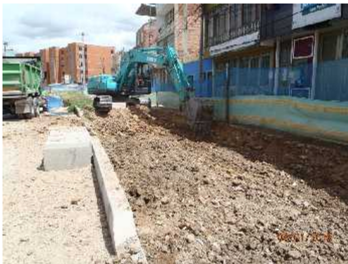
Foto 86. Excavación K0+620, espacio público, abscisa izquierda.
