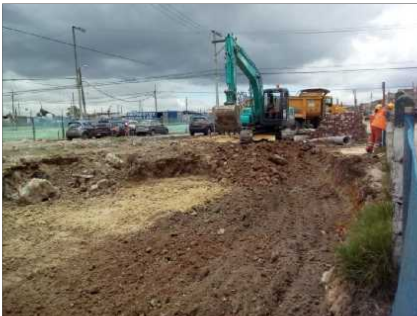
Foto 24. Excavación carril derecho K1+080 – K1+150
