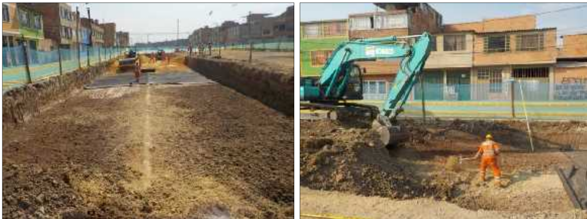
Foto 11. Excavación de vías K620-K780. Resultado negativo.
