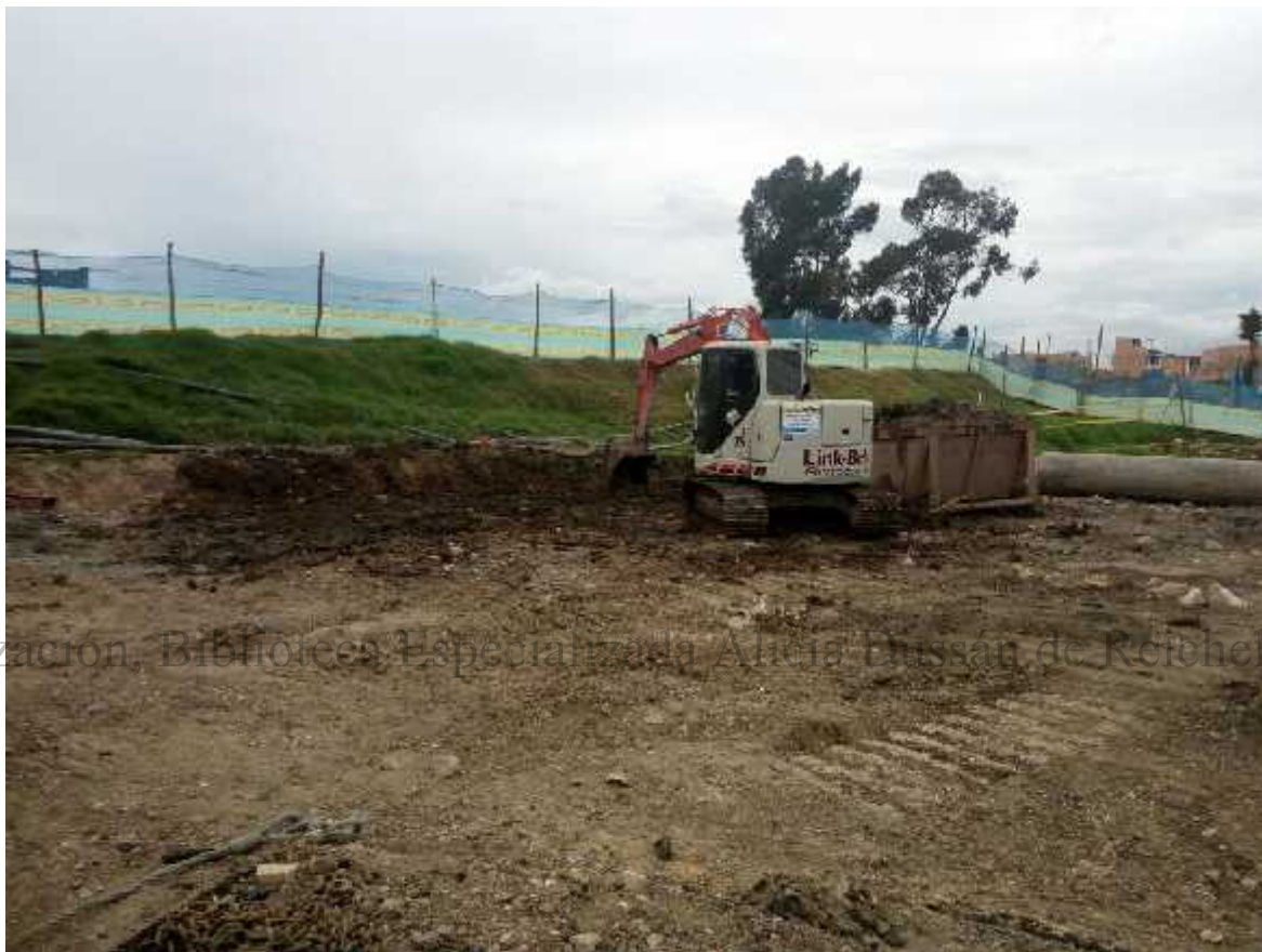
Foto 116. Excavación mecánica barrio La Paz, abscisa izquierda K1+710
