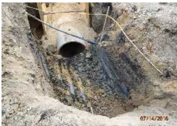
Foto 77. Proceso de excavación K1+170
