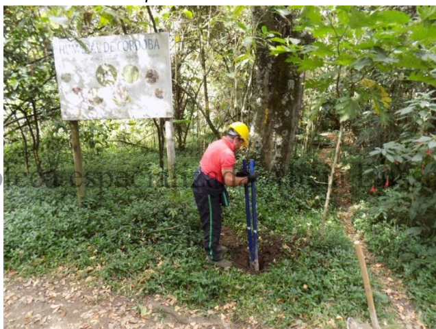
Fotografía 6. Realización pozo de sondeo lado nororiental del humedal
