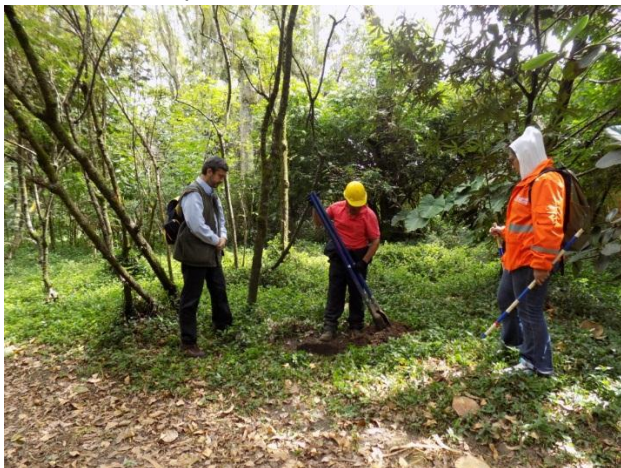
Fotografía 5. Realización pozo de sondeo lado noroccidental del humedal
