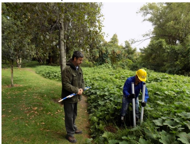
Fotografía 13. Realización pozo de sondeo lado suroccidental del humedal
