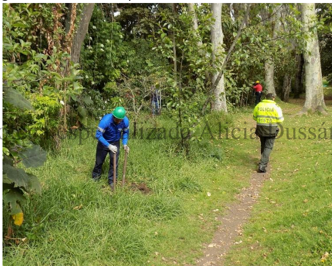
Fotografía 9. Realización pozo de sondeo lado norte del humedal
