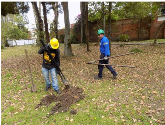
Fotografía 10. Realización pozo de sondeo lado norte del humedal
