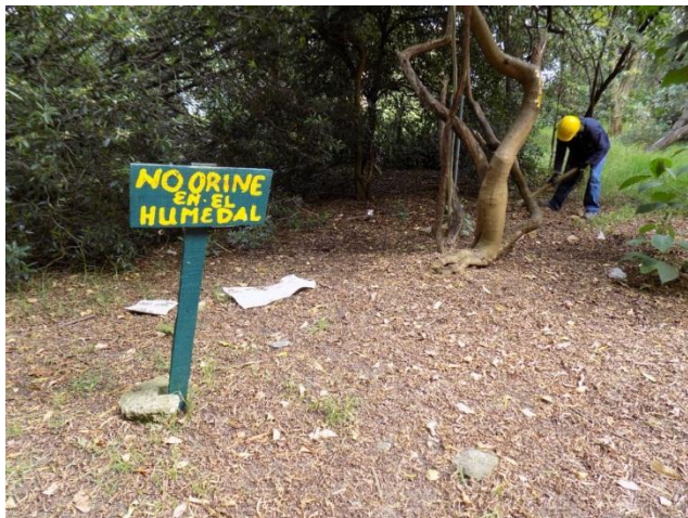
Fotografía 11. Realización pozo de sondeo lado nororiental del humedal
