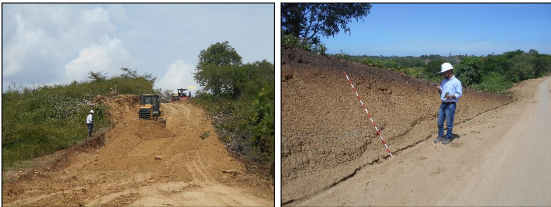
Foto 21 y 22. Registro del perfil modal en el área 4 de la vía de acceso.
