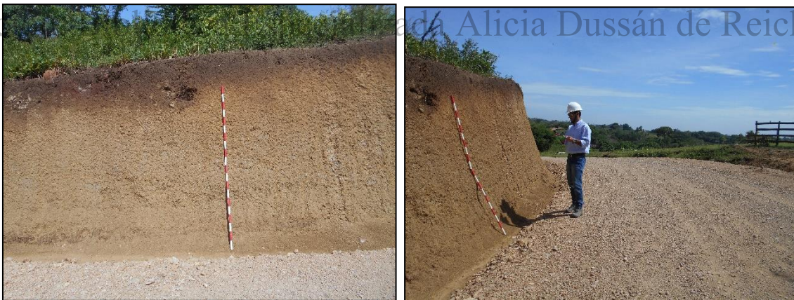
Foto 19 y 20. Registro del perfil modal en el área 4 de la vía de acceso.
