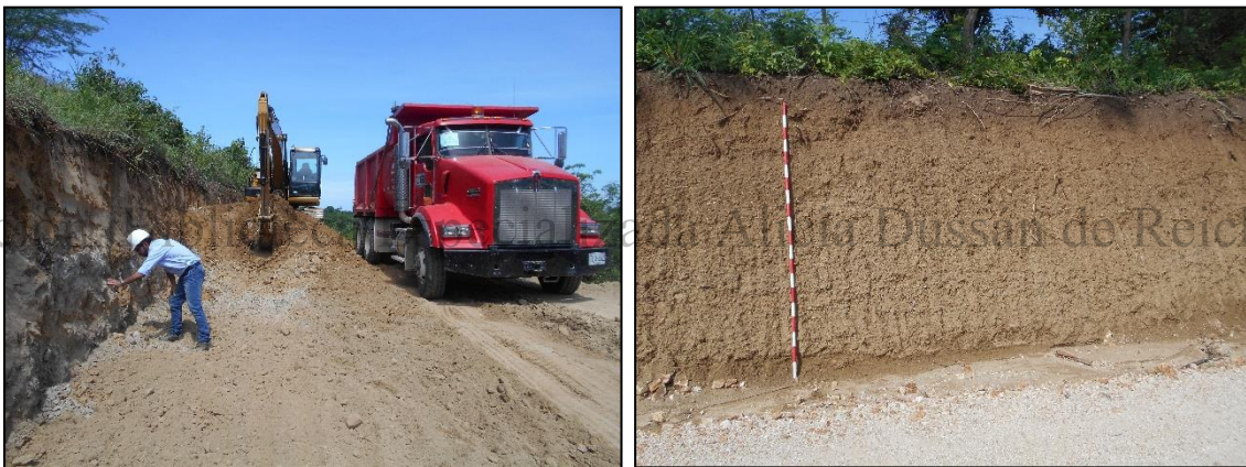
Foto 17 y 18 Labores de monitoreo y registro del perfil modal en el área 5 de la vía de acceso.
