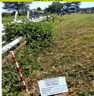
Fotografía 119 Punto de PS 1215 proyectado sobre terraplen de carretera principal. E 1017348,3 N 1267691,4
