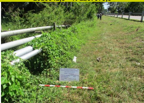
Fotografía 118 Punto de PS 1207 proyectado sobre infraestructura de líneas mecánicas y carretera E 1017348,0 N 1267511,4
