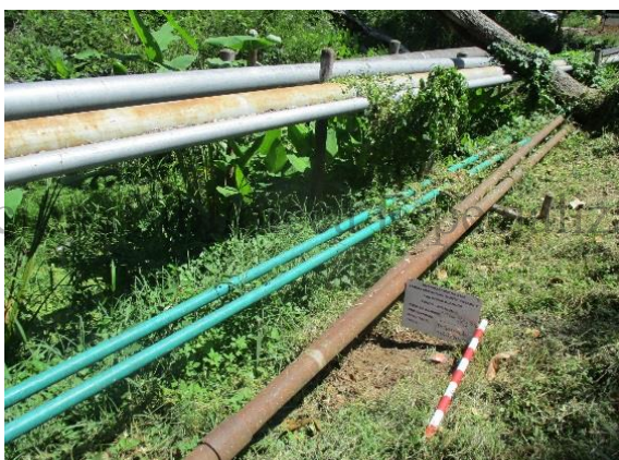
Fotografía 109 Línea mecánica en donde se ubica PS proyectado 1653. E: 1018190 N: 1270244
