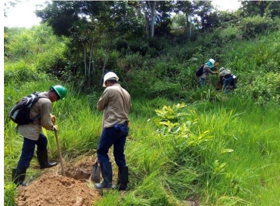
Fotografía 3 Excavación de pozos de sondeo.
