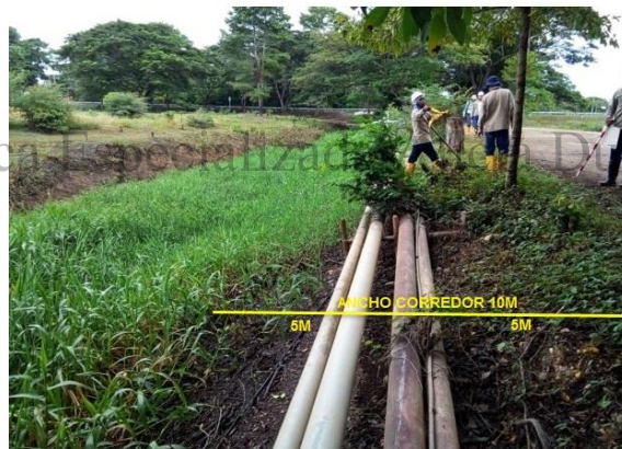
Fotografía 115 Intervención de infraestructura petrolera sobre corredor línea Norte Casabe; asociado el PS 2150.
