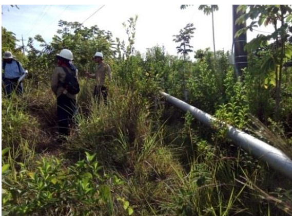
Fotografía 23 Infraestructura petrolera, líneas mecánicas PS 873. E 1014882,4 N 1263697,4
