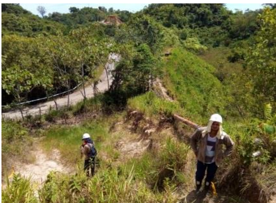
Fotografía 25 Líneas mecánicas y carretera. PS 754. E 1014818N1262891,9
