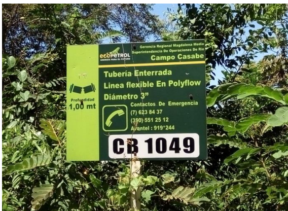
Fotografía 120 Aviso tubería enterrada Línea flexible en polyflow 3" asociada al punto PS 1137 proyectado. E 1017091,8 N 1267079,7
