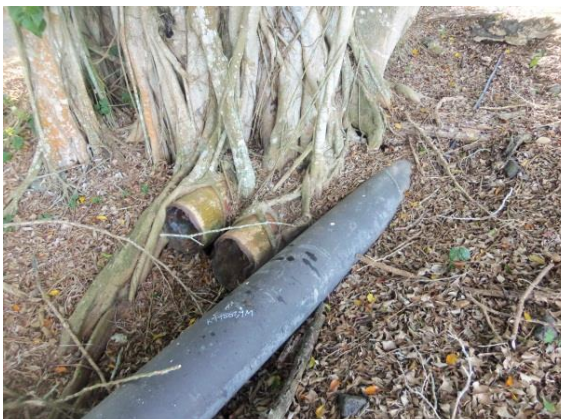
Fotografía 104. Líneas de flujo en uso y desuso, bajo raíces arbóreas, asociado al PS 1720 en llanura aluvial. E 1018549,8 N 1270297,7
