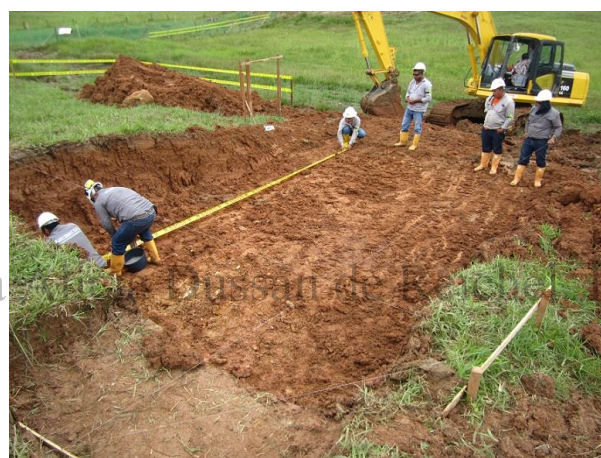
Foto 31 Continuación de la excavación con retroexcavadora Foto 32 Continuación y delimitación de las excavaciones para el polvorín
