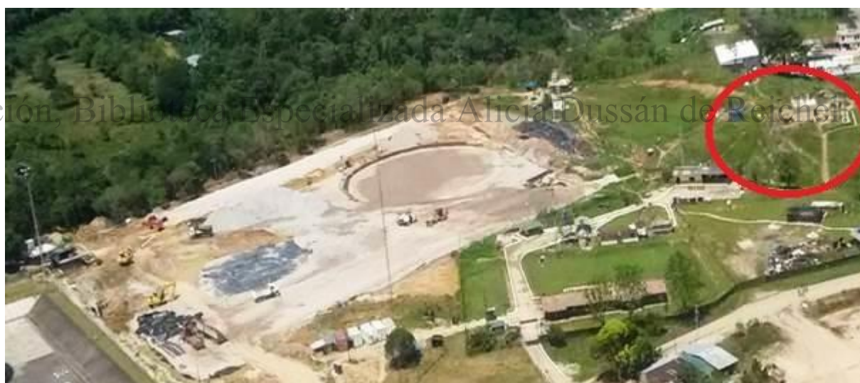
Foto 22 El área con el círculo del tanque N° 02 excavado (en esta área se hicieron 3 recolecciones de material)
