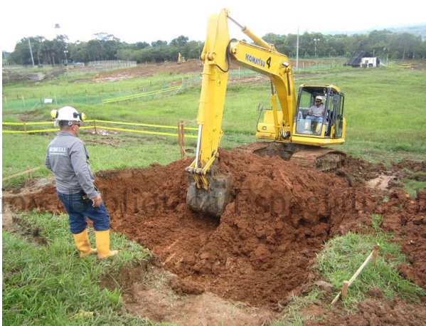
Foto 31 Continuación de la excavación con retroexcavadora Foto 32 Continuación y delimitación de las excavaciones para el polvorín
