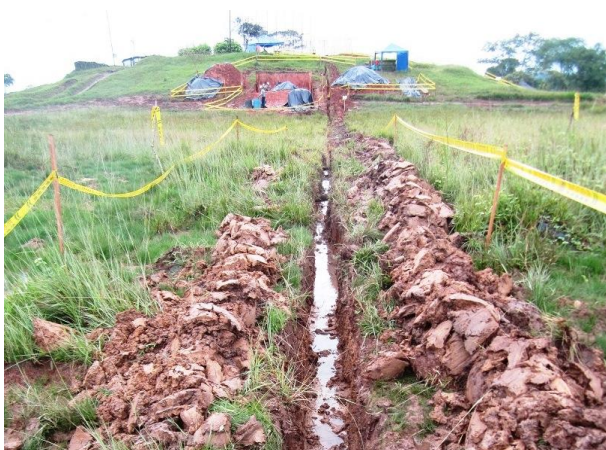
Foto 25 Excavación trinchera para instalaciones eléctricas (al fondo terraza de las banderas)
