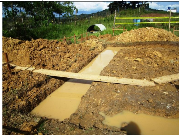
Foto 37 Excavación de trincheras para fundación de muros del bunker N° 02 Foto 38 Note the flooding of the trench due to the shallowness of the water table
