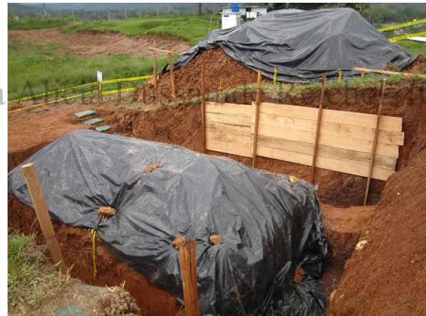
Foto 35 Excavación para fundación y bases de los muros del polvorín
