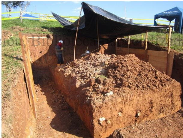
Foto 35 Excavación para fundación y bases de los muros del polvorín
