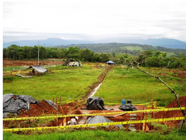
Foto 25 Excavación trinchera para instalaciones eléctricas (al fondo terraza de las banderas)
