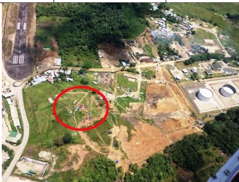
Foto 21 El área descapotada y con intervenciones en la terraza del hallazgo
