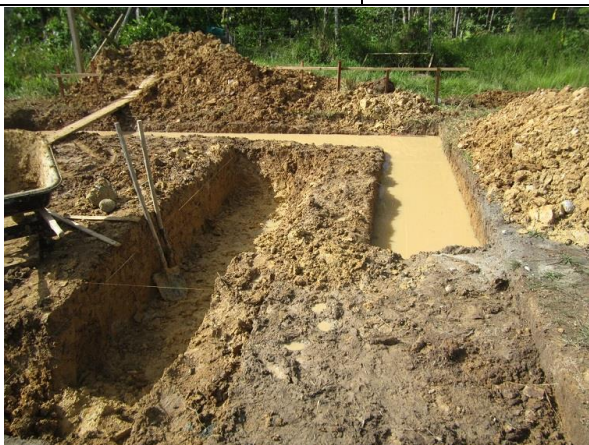
Foto 37 Excavación de trincheras para fundación de muros del bunker N° 02 Foto 38 Note the flooding of the trench due to the shallowness of the water table
