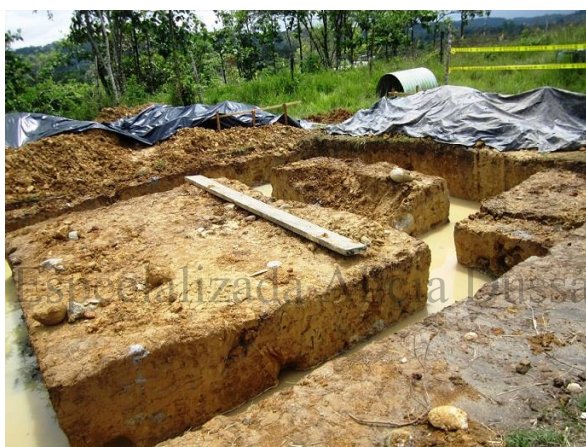
Foto 39 Trincheras terminadas para los muros del bunker N°02 en el costado nororiental del área
