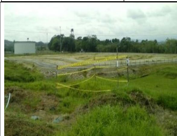
Costado Occidental, frente a tanques nuevos, dentro de la BASMIL la Cristalina.
