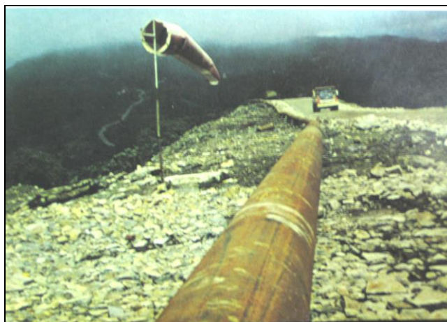
Foto 9 Oleoducto y carretera de acceso recién construidos páramo de Alisales (Fuente: Revista Progreso, 1969: 43)
