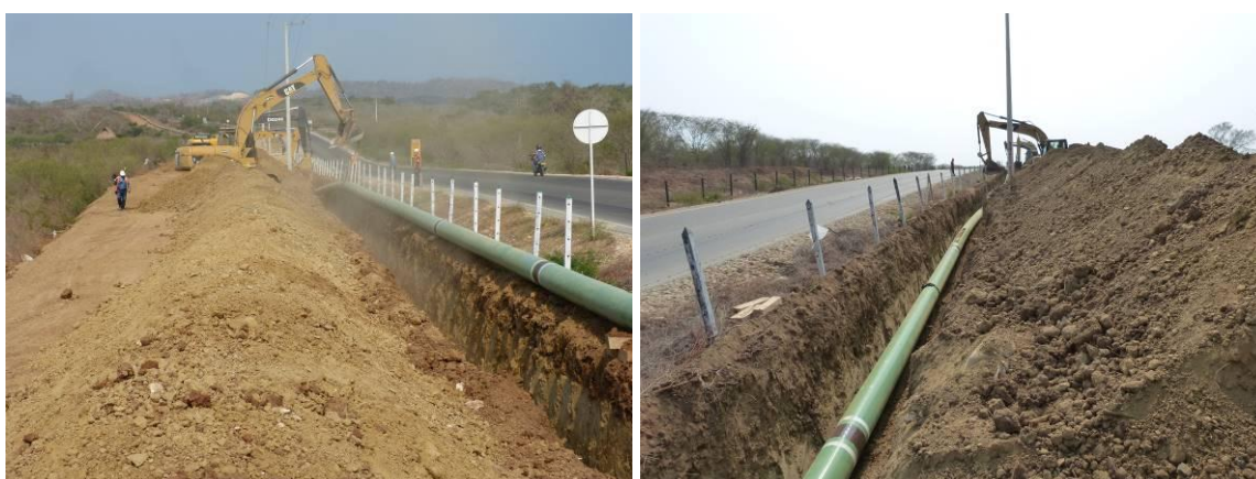
Foto 44. Acomodación y bajada de tubería frente al predio “El Kiosco”.
