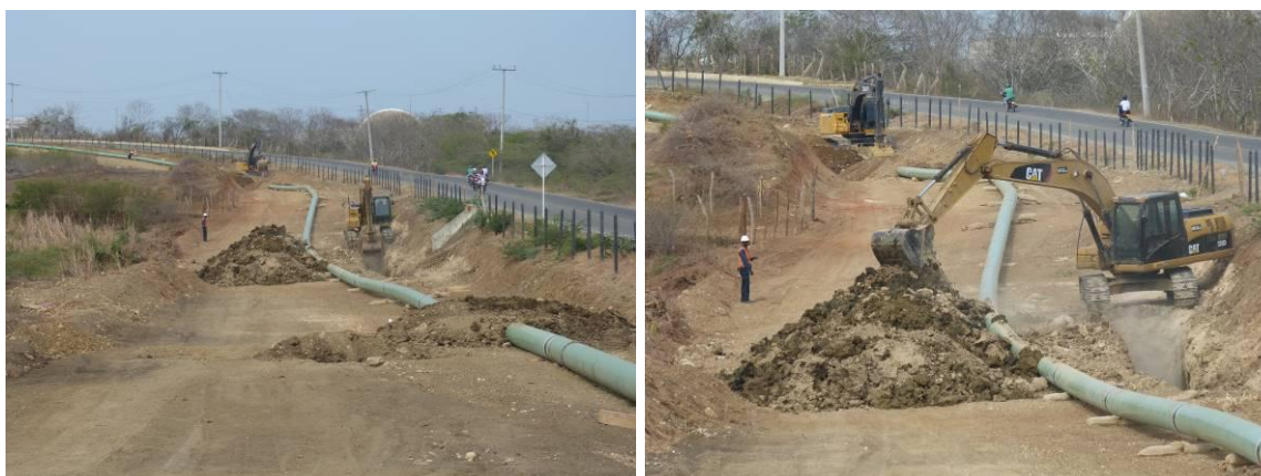
Foto 53. Zanjado de tramo previo al lote frente al puerto El Cayao.
