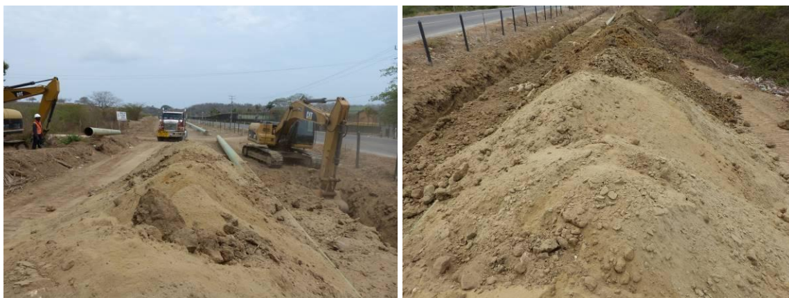
Foto 50. Banco o depósito de arena natural en el tramo frente a Pescador de Colores.
