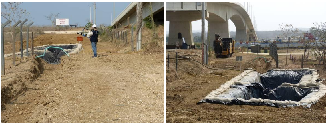
Foto 35. Piscina para material de excavación dirigida sector Canal del Dique.
