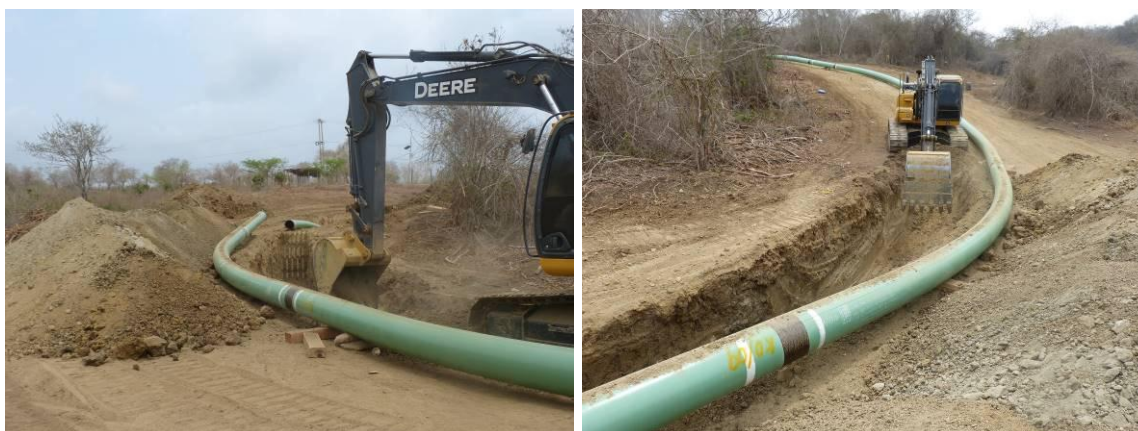
Foto 55. Excavación final del trazado frente al puerto El Cayao, nótese el punto de empate con la perforación dirigida.
