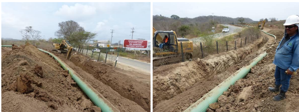
Foto 56. Excavación de zanjado frente al puerto El Cayao, único sector en donde la línea se separa unos pocos metros de la vía principal.
