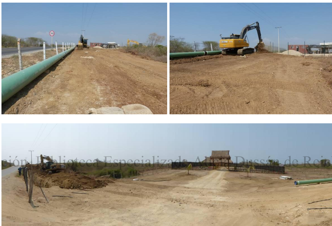
Foto 43. Inicio zanjado frente al predio “El Kiosco”.
