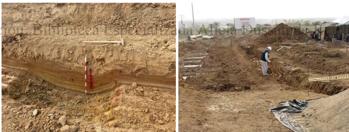
Foto 38. Zanjado para inserción de tubería.
