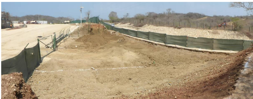
Foto 26. Entrada al puerto El Cayao en el costado opuesto a dónde va la línea del gasoducto sobre la vía Barú – Cartagena.
