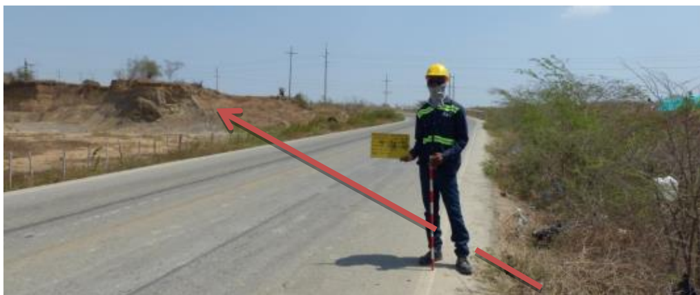
Foto 15. Paso sobre la carretera de la línea del gasoducto, al fondo se observa la cantera.
