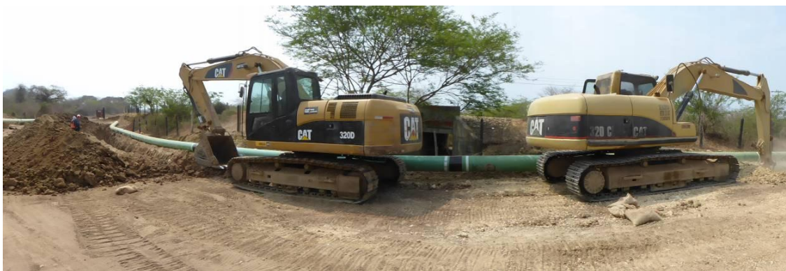
Foto 48. Excavación tramo frente a Pescador de Colores, área donde se reportaron fragmentos cerámicos durante la prospección.
