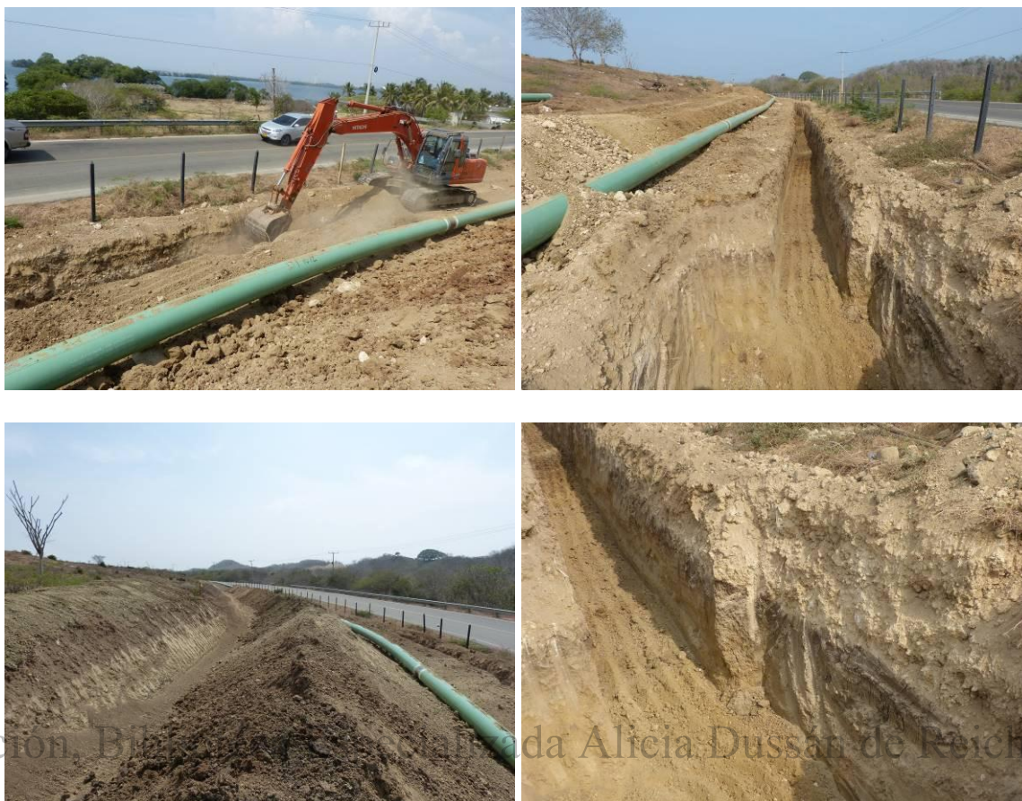
Foto 52. Detalle de zanjado frente al predio “La Loma”.
