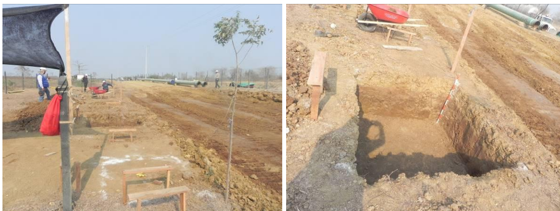
Foto 37. Excavación para zapatas de la válvula de seguridad.
