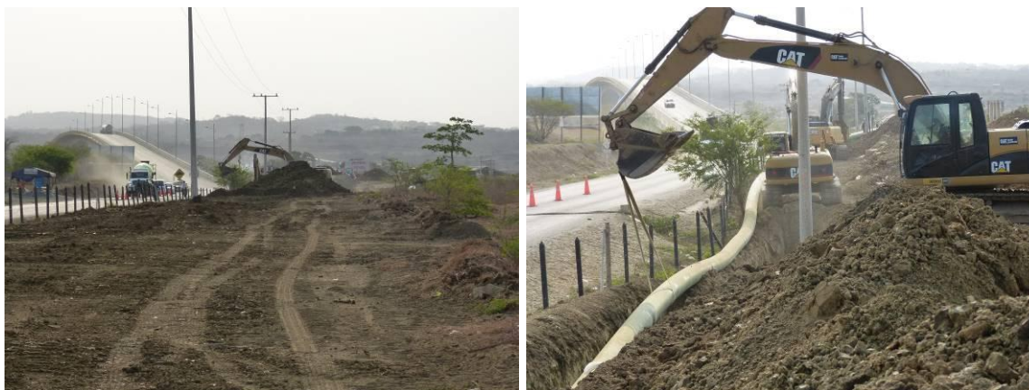
Foto 41. Excavación de zanja en sector del dique.
