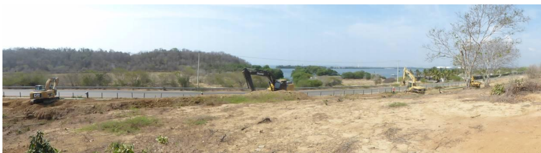
Foto 51. Zanjado frente a predio “La Loma”.
