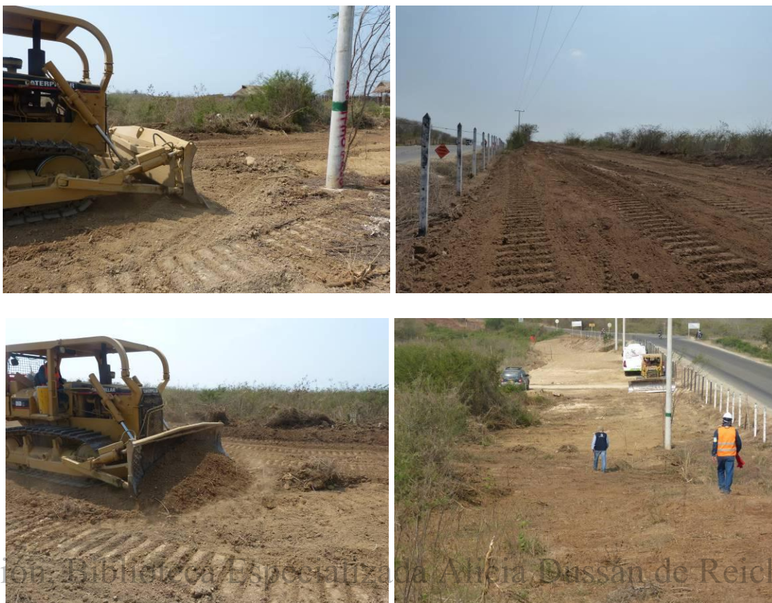
Foto 28. Descapote sector cerca al predio “El Kiosco”, nótese la cercanía a la vía y la intervención antrópica del terreno.
