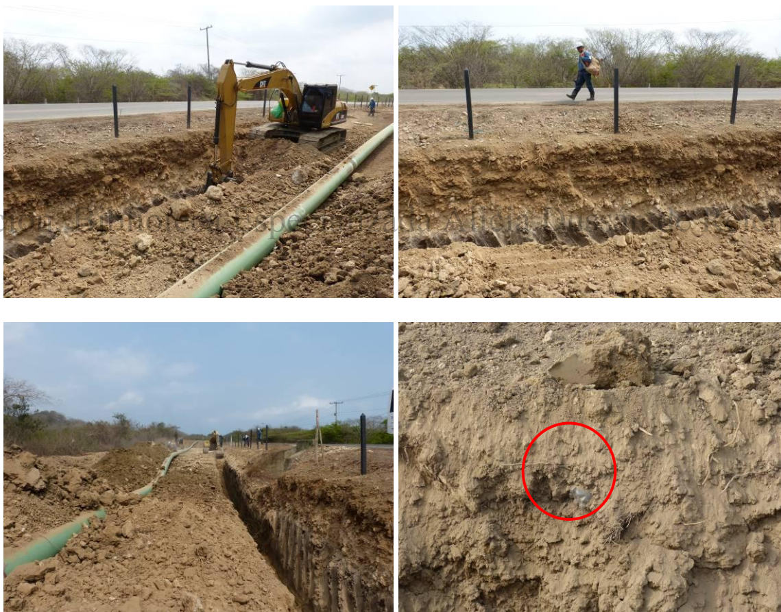
Foto 49. Excavación tramo frente al restaurante Pescador de Colores, nótese la cantidad de relleno utilizado para el terraplén, detalle de basura a aproximadamente 70 cm del descapote.
