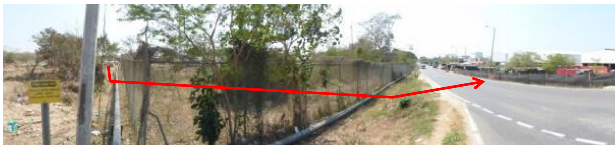
Foto 20. Panorámica de la empresa YARA (antiguo ABOCOL). Nótese el trazado de la línea por áreas altamente intervenidas.
