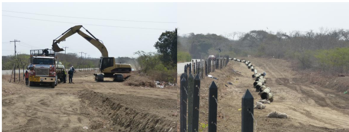
Foto 31. Extendida de tubería.
