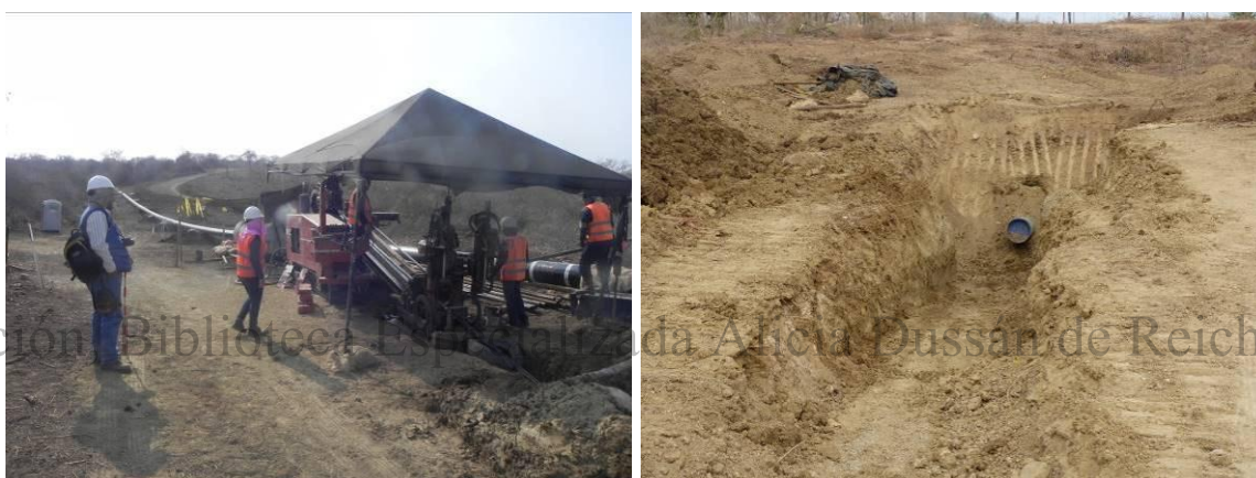
Foto 34. Taladros de perforación dirigida utilizados en el desarrollo del gasoducto y disposición final de la tubería.
