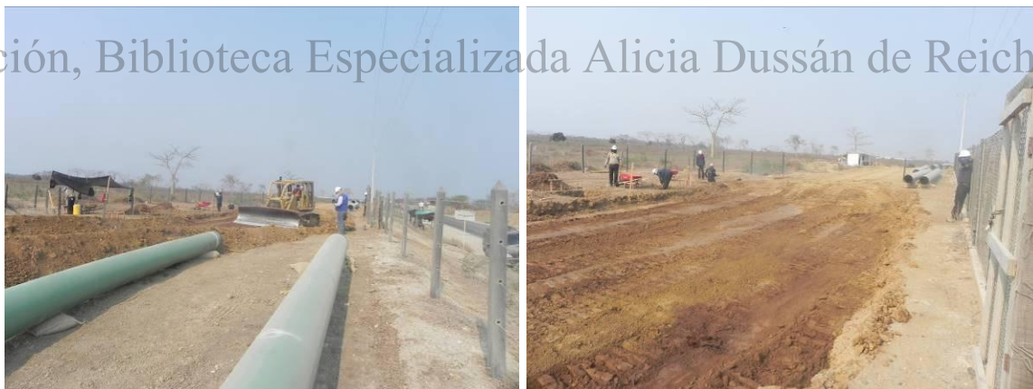
Foto 36. Aplanamiento área de caseta para válvula de seguridad.
