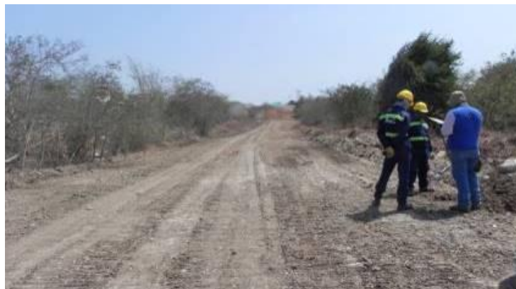
Foto 12. Tramo del área de prospección desmalezado previo a la excavación.
