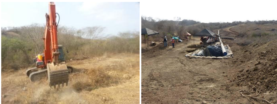
Foto 33. Excavación de piscina frente al puerto El Cayao.
