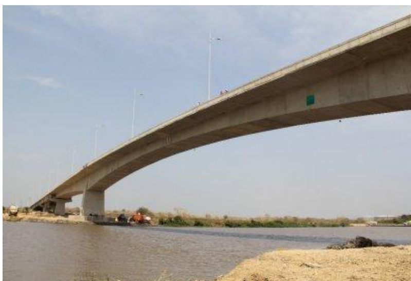
Foto 1. Puente Barú sobre el Canal del Dique.
