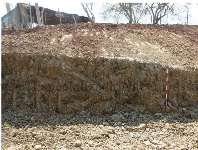
Foto 27. Detalle de perfil expuesto en la entrada al área de construcción del puerto El Cayao.
