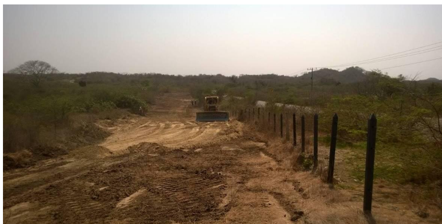
Foto 40. Con esta actividad se completó el 100% del descapote del derecho de vía para la línea del gasoducto.
