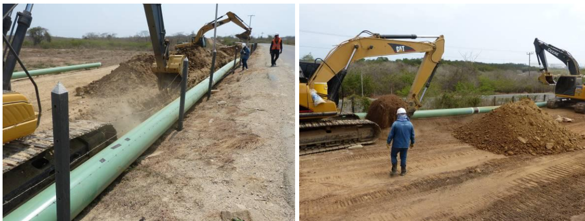
Foto 46. Excavación de zanjado en el lote anterior a Puerto Bahía.
