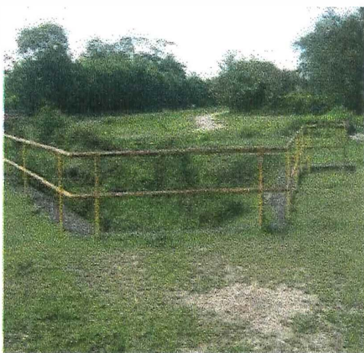
Foto No 14. Cruce de la vía con canal de riego. Kilómetro 3+400
