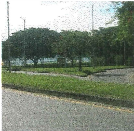
Foto No 16. Fin de la variante. Cruce con glorieta. Kilómetro 3+900
