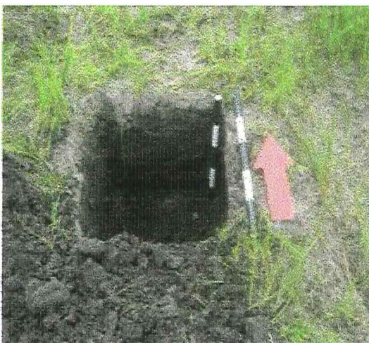
Foto No 20. Pozo de sondeo. Kilómetro 1+400
