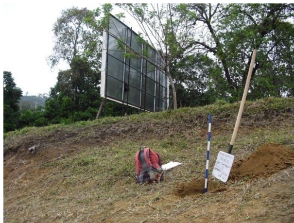
Foto 32. Valla publicitaria instalada sobre la terraza
