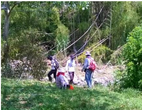
Foto 68. Realización de pozos de sondeo en la Fuente de Materiales (Tomada en las coordenadas N 5°04'11.6" W 75°38'41.4")
