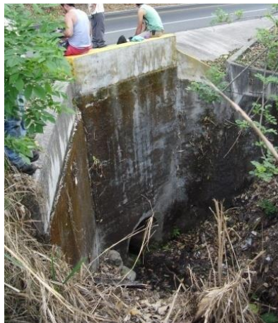
Foto 16. Drenaje de vía existente
