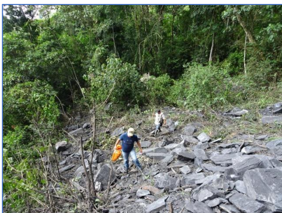
Fotos N°28 y 29. El tránsito peatonal por esta zona es difícil debido a la topografía escarpada y la alta cantidad de lajas desprendidas.
