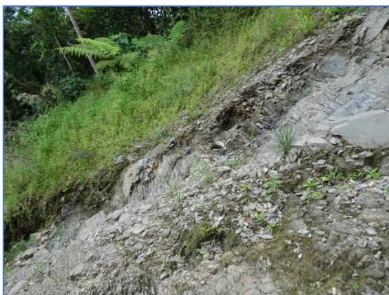
Fotos N°48 y 49. Esta ladera fue descubierta de vegetación y tiene problemas de erosión y estabilidad.
