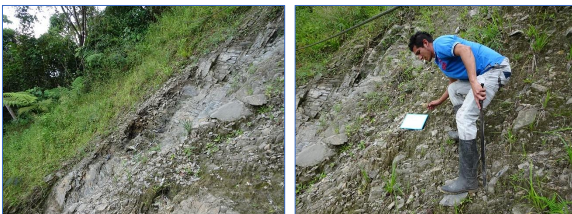
Fotos N°42 y 43. Ladera escarpada donde será instalada la bocamina 4.
