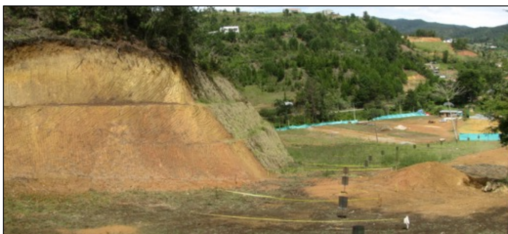
Foto 7. Área Removida: vista desde el sector Este hacia el Oeste (delimitación de parqueaderos)
