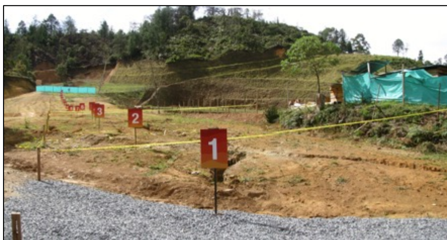
Foto 5. Área Removida: vista desde el sector Oeste hacia el Este (delimitación de parqueaderos)
