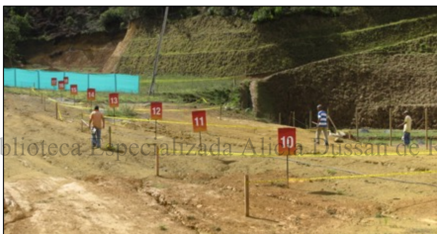
Foto 6. Área Removida: vista desde el centro del polígono
