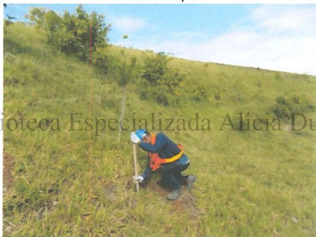
Fotografía 8. Panorámica realización pozo de sondeo ladera terraza
