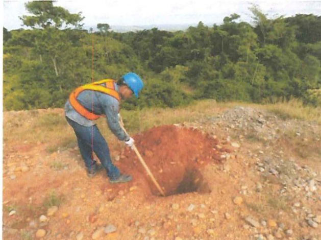
Fotografía 4. Panorámica realización pozo de sondeo
