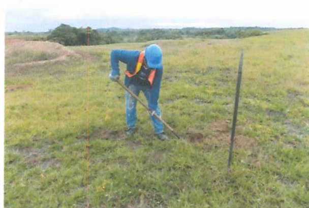
Fotografía 14. Panorámica realización pozo de sondeo
