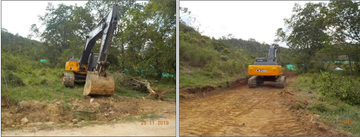
Fotografía 5-8 Antes y durante la excavación de la Vía de acceso
