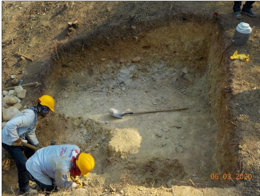
Fotografía 5-17 Labores de excavación
