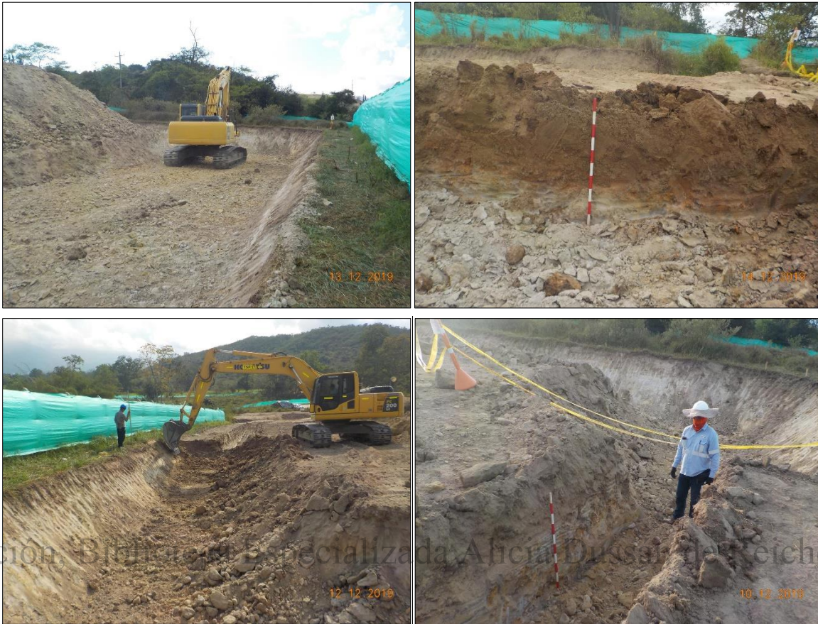
Fotografía 5-14 Remoción de tierras en el área 2
