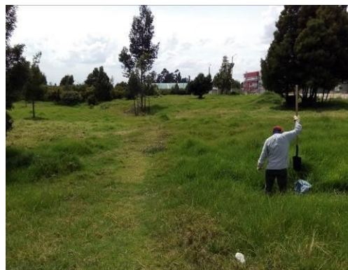
Fotografía 8. Realización pozo de sondeo 2A
