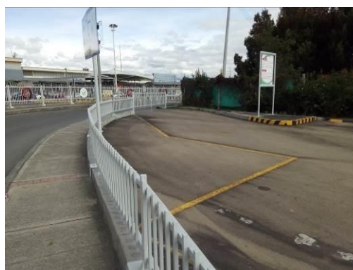
Fotografía 33. Cerramiento metálico, áreas de parqueo, sector sur del auditorio
