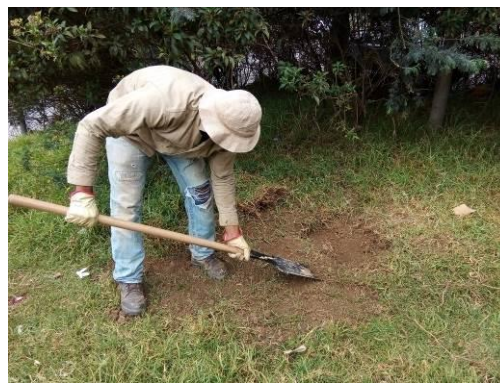
Fotografía 6. Tapado de sondeos, sector sur
