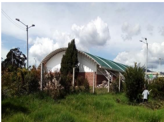
Fotografía 30. Auditorio recientemente construido dentro del área del polígono
