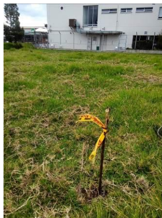
Fotografía 2. Estacado de puntos de sondeo
