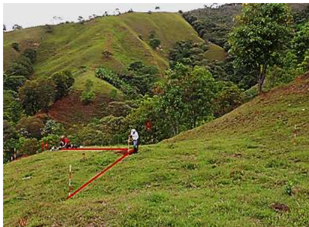
Foto 9. Prospección y pruebas de sondeo en la Central Hidroeléctrica de Los Andes -HIDROANDES-, vereda El Higuierón, municipio de Planadas - Tolima,
