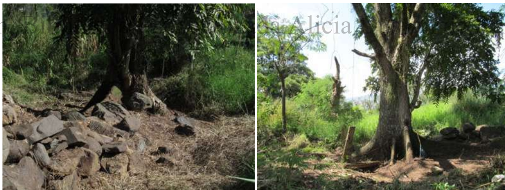
Fotos 108 y 109 Árbol de cedro que creció encima de la estructura.
