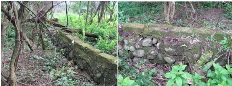
Fotos 40 y 41 Muro reciente, con concreto como mortero entre las piedras e hilada de adobe macizo en la parte superior.
