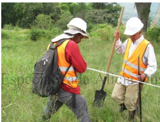
Foto 46 Ubicación de sondeos mediante lienza.
