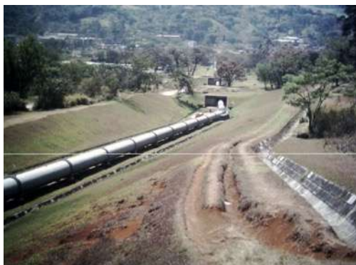
Foto 32 Sifón o Conducción de Agua Niquía-Manantiales.
