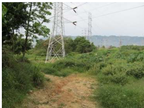
Foto 37 Torres y línea de alta tensión que atraviesa el predio por el medio y será trasladada al inicio de las obras.
