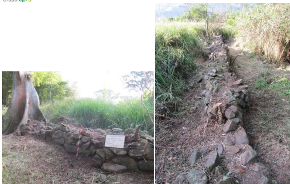
Fotos 110 y 111 Muro 2 – vistas lateral y frontal.
