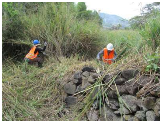
Foto 57 Limpieza de estructuras en piedra con machetes y rastrillo.
