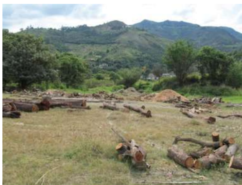
Foto 74 Área sin cobertura de suelos y con afirmado de gravilla, sobre la cual existió un depósito de tubería de EPM y en la actualidad se almacenan los escombros de la tala forestal por parte de la obra.
