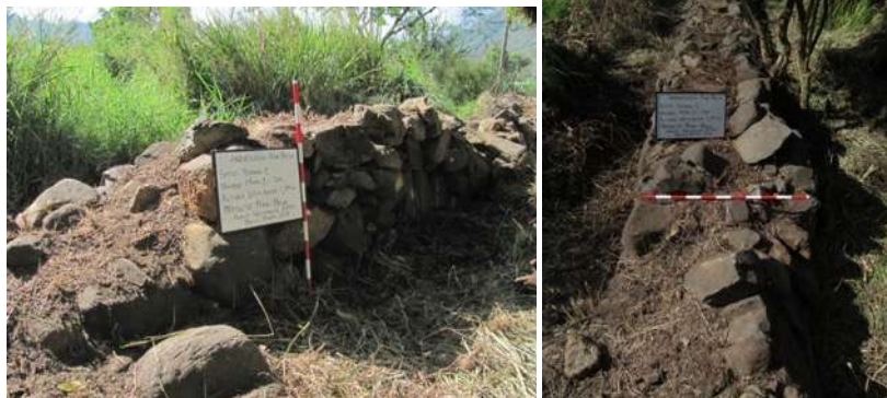
Fotos 106 y 107 Muro 1
