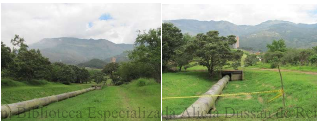
Fotos 33 y 34 Cruce del sifón y su depresión, con el terraplén de la antigua vía férrea, donde se construyó un viaducto por encima de la tubería. Al fondo, y fuera del límite del predio el cerro Quitasol y otro cerro más bajo.
