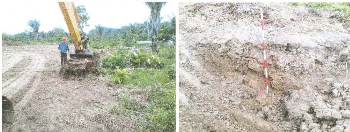
Foto N° 15. Realización de excavación con retroexcavadora en el límite q colinda con el bosque de galería perteneciente a la ronda del río Pauto, obsérvese el suelo homogéneo en toda el área de la locación.
