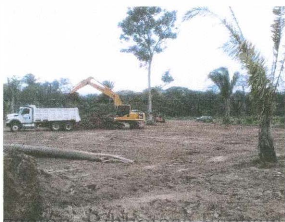
Foto N° 13. remoción de arboles y desplazamiento de material en volquetas.
