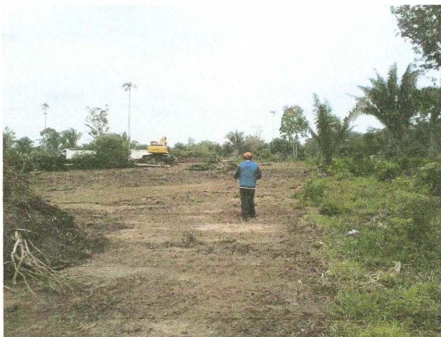
Foto N° 12. Recorrido y barrido visual durante el descapote de la locación
