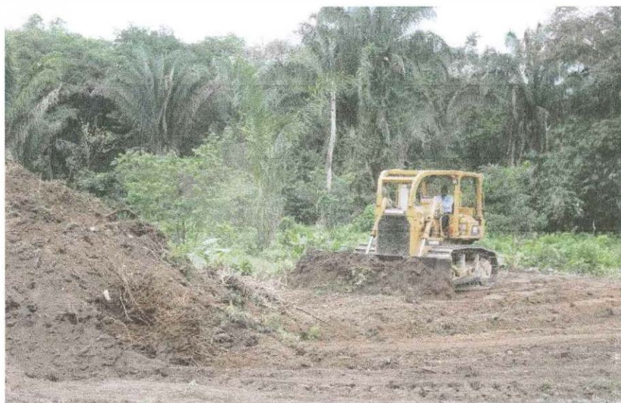
Foto N° 10. Inicio del descapote en el área de la locación
