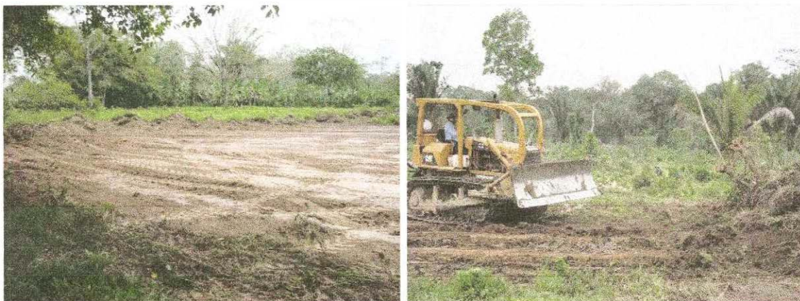
Foto N° 11. descapote del área de la locación Petirrojo Sur 1.
