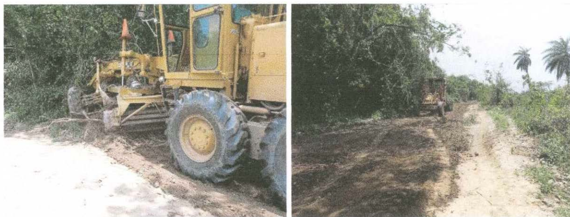
Foto N° 6. Inicio del proceso de descapote mediante la utilización de moto niveladora
