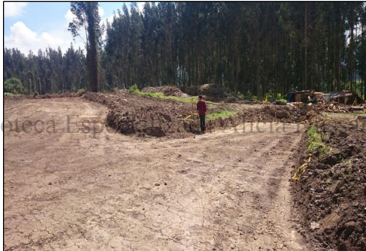
Fotografía 3 Revisión superficial en el área a prospectar No. 1
