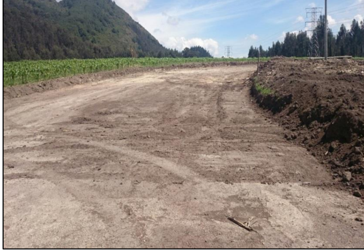
Fotografía 2 Obras hechas en el área a prospectar No. 1 (vista norte)
