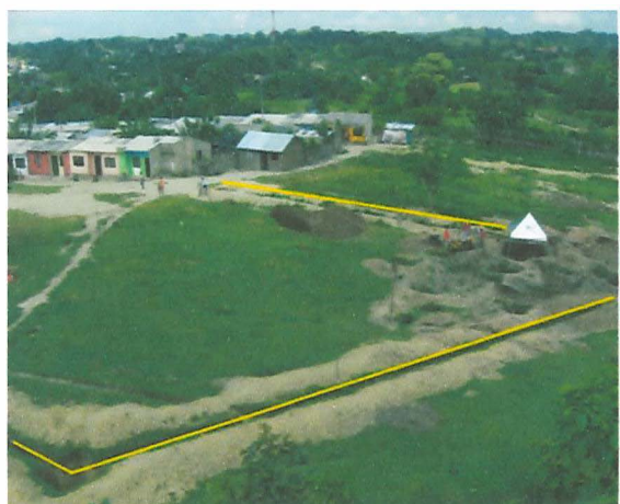
Foto N°20. Trincheras para alcantarillado.
