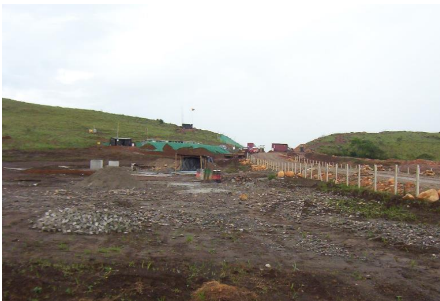
FOTOGRAFÍA No. 10 FECHA: Enero de 2006 LUGAR: Vereda Bajo Yucapé Municipio de El Castillo OBSERVACIONES: Monitoreo al movimiento de tierras en la construcción del campamento para la construcción de la vía
