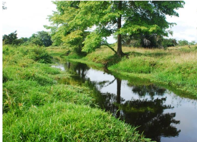
Fotografía 5-8 Canales artificiales para drenar el nivel freático de los potreros
