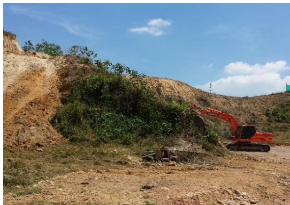
Fotografía 1 Actividades de desmonte, descapote y limpieza
