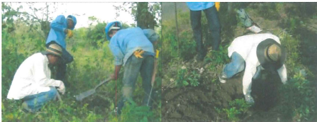
Foto 8. Realización de Pozo de Sondeo.
