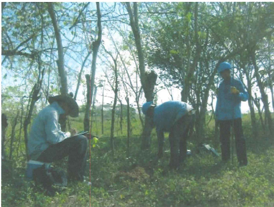
Foto 7. Pozos de sondeo y registro.
