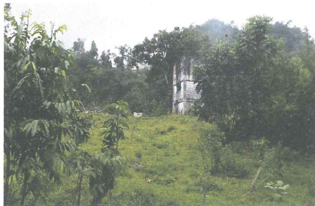
Foto 7, estructura, posible tanque de agua.
