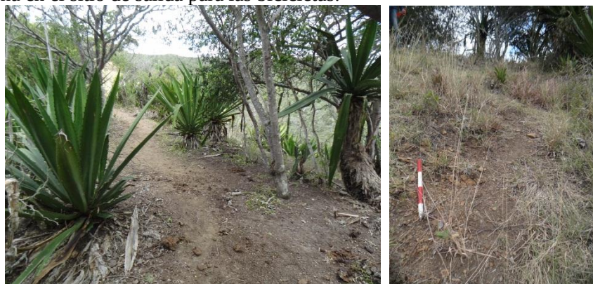
Izquierda: superficie expuesta en área con arbustos. Derecha: suelo denudado en pendiente del descanso de ladera.
