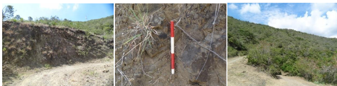
Izquierda y centro: talud expuesto en una curva de la vía, punto 3 del polígono. Derecha: vista de la cantera desde el punto 3.
