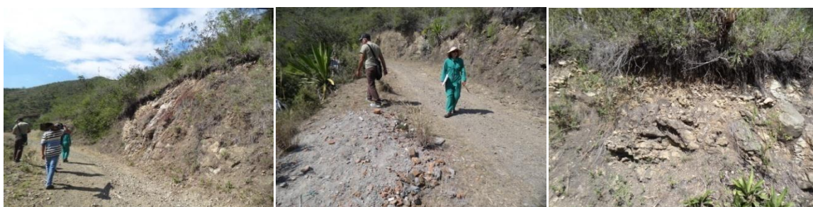
Izquierda: recorrido en la parte baja. Centro: ascenso en la parte media donde se observan escombros en la vía. Derecha: talud expuesto en la vía.
