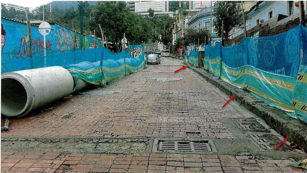
Panorámica de la calle 12C. La flecha esta señalando los sillares de piedra en las condiciones en que se encontraban antes del inicio de las obras de traslado de la red de alcantarillado.
