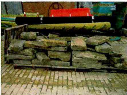
Punto de Acopia de los sillares de piedra dentro del cerramiento de la obra
