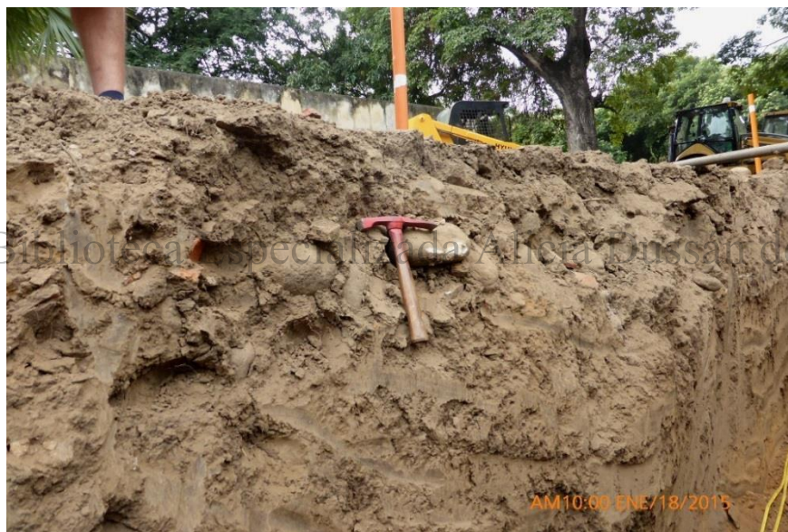
FOTO 14, ALINEAMIENTO DE ROCAS HACIA LA PARTE FINAL DE LA ZANJA
