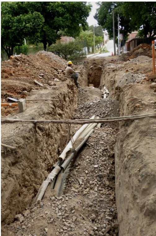
FOTO 38. TENDIDO FINAL DE LA TUBERÍA
