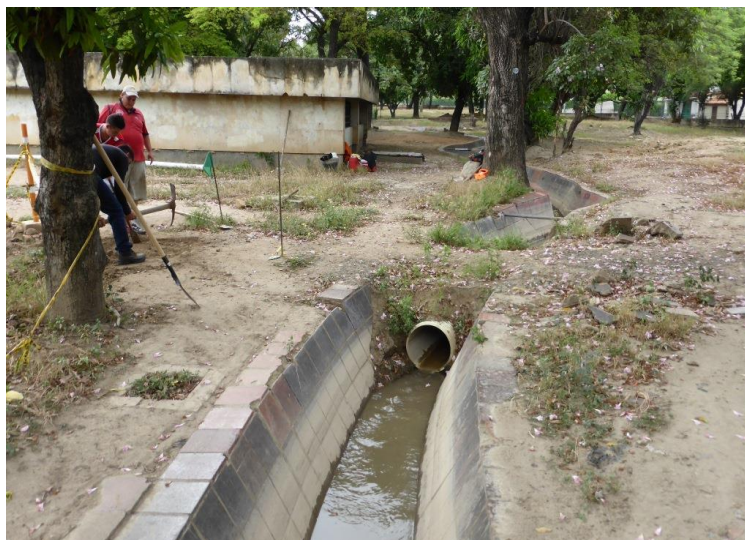
FOTO 18. ACEQUIA A LA ALTURA DE LA CALLE 10
