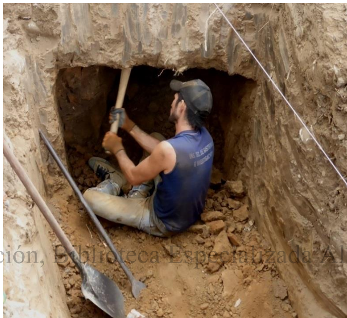
FOTO 30. CONSTRUCCION DEL TÚNEL PARA TENDIDO DE LA TUBERÍA
