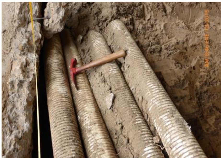
FOTO 8. TUBERÍAS DE PVC QUE ATRAVIESAN LA ZANJA
