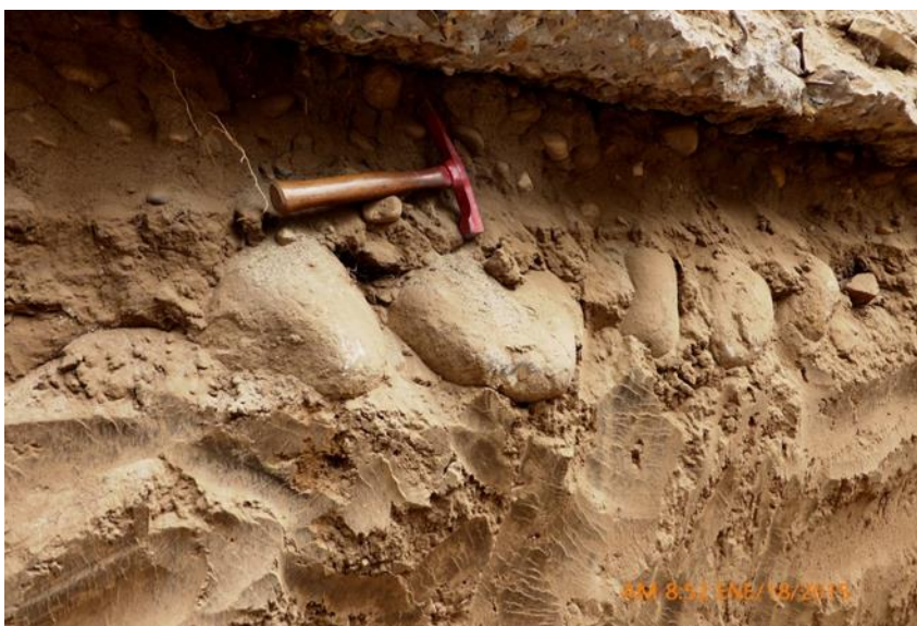
FOTO 9. ALINEAMIENTO DE ROCAS BAJO EL PISO DE CONCRETO
