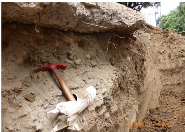
FOTO 7. RESTOS DE TUBERÍA DE BARRO DE DRENAJE Y TUBERÍAS DE PVC
