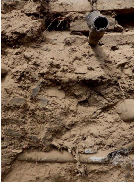
FOTO 36. TUBERÍAS DE PVC Y ETERNIT EN EL PPERFIL DE LA ZANJA
