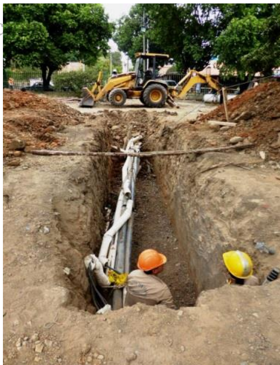
FOTO 33. EXCAVACIÓN DE LA PARTE FINAL DE LA ZANJA
