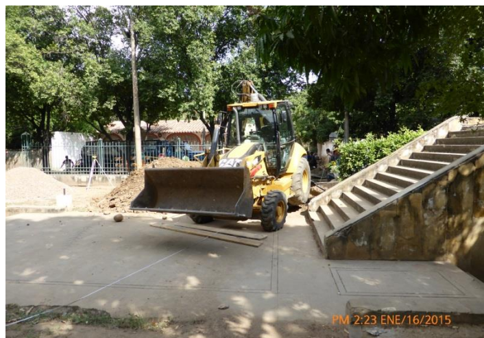
FOTO 2. ESCALERAS Y ANDÉN INTERNO
