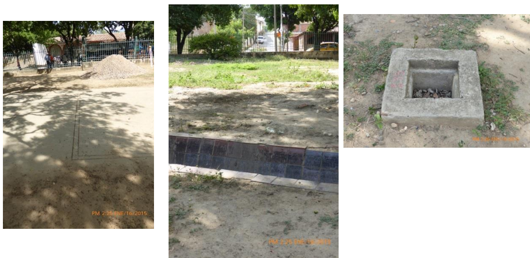
FOTO 1. ANDÉN INTERNO, ACEQUIA Y SISTEMA DE RIEGO
