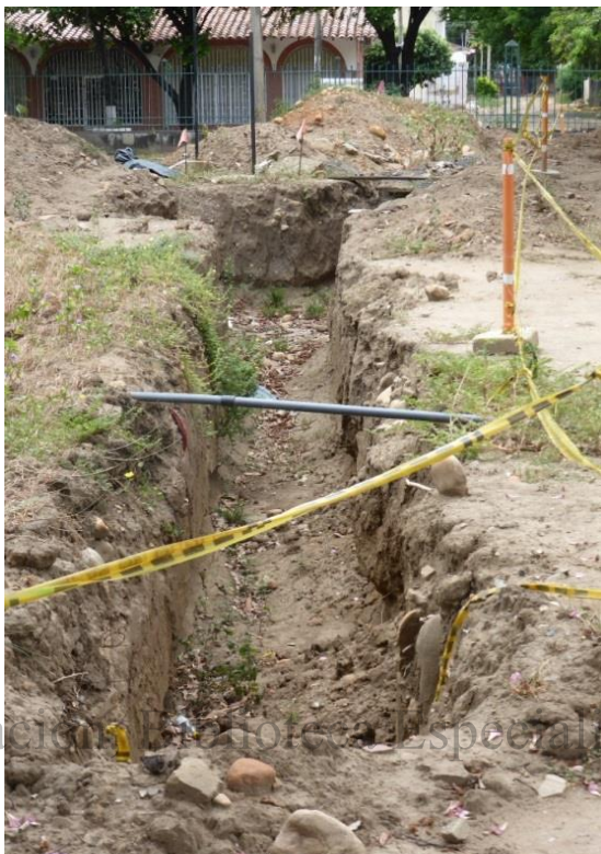
FOTO 17. ZANJA EXCAVADA PARA LA INSTALACIÓN DE LAS TUBERÍAS
