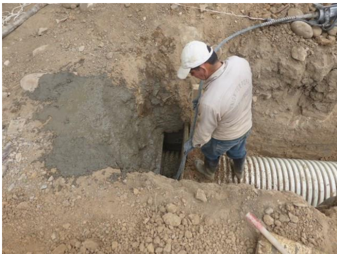
FOTO 32. LLENADO DE ESPACIOS EN EL TUNEL
