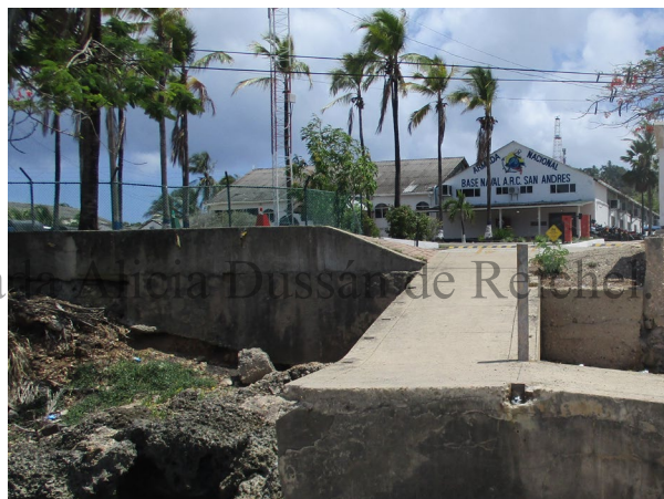
Fotografía F: Estructura en concreto del muelle actual, al fondo base naval.
