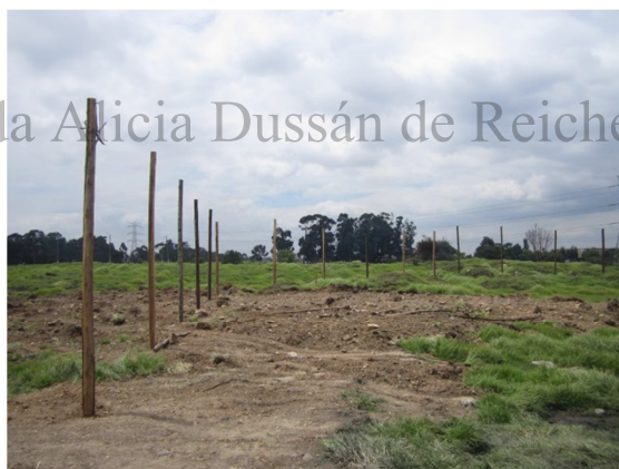
Fotografía 4-12 Cerramiento perimetral Fuente: Monitoreo arqueológico SVC Tunal.
