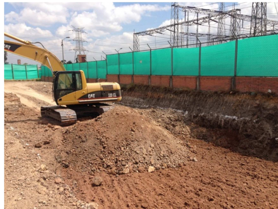
Fotografía 4-6 Zona de excavación profunda Fuente: Monitoreo arqueológico SVC Tunal. 2014
