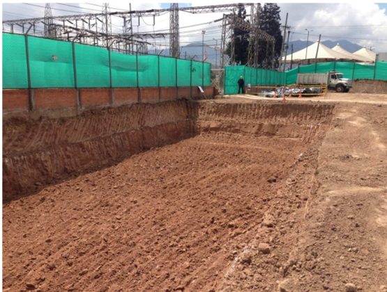
Fotografía 4-5 Zona de excavación profunda Fuente: Monitoreo arqueológico SVC Tunal. 2014
