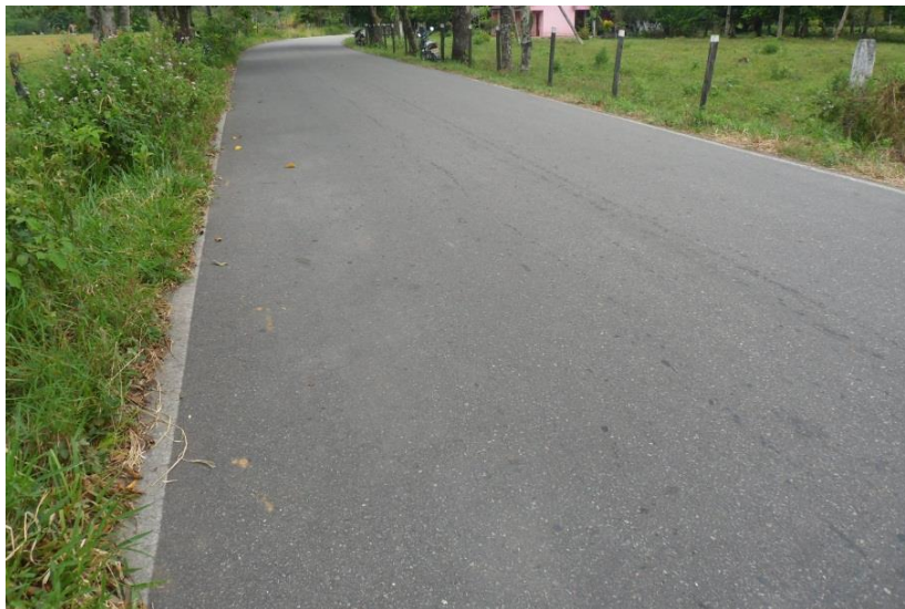
Fotografía 2. Zona intervenida por vía que conduce de Guamal a Castilla.
