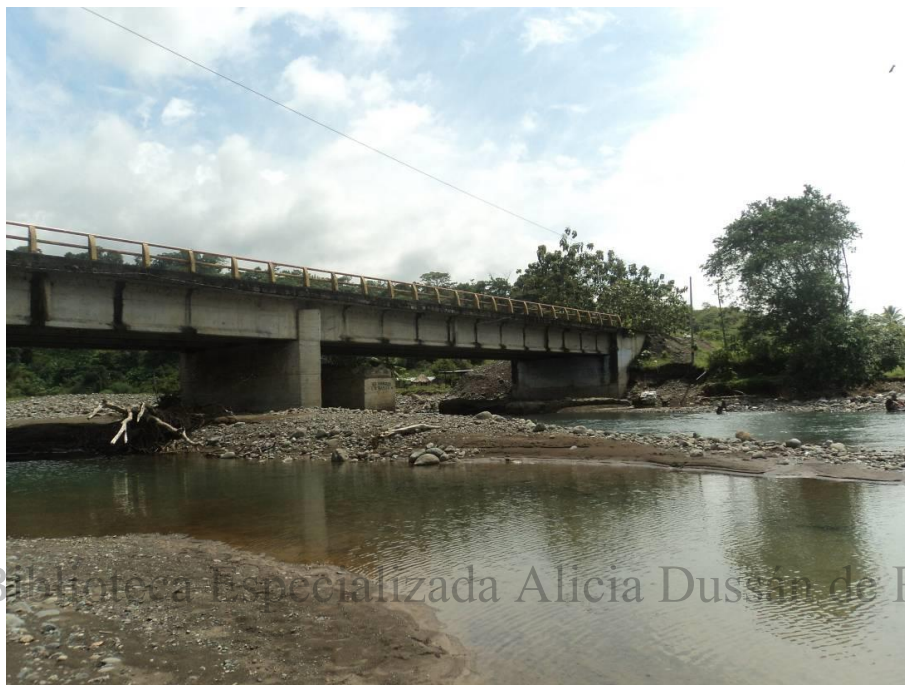
Fotografía 7. Zona de la concesión minera atravesada por el puente de la autopista Medellín Turbo (No. 62). Se pueden apreciar los depósitos de materiales en ambas columnas del puente y el acceso existente para vehículos de carga desde la autopista en un costado del puente.
