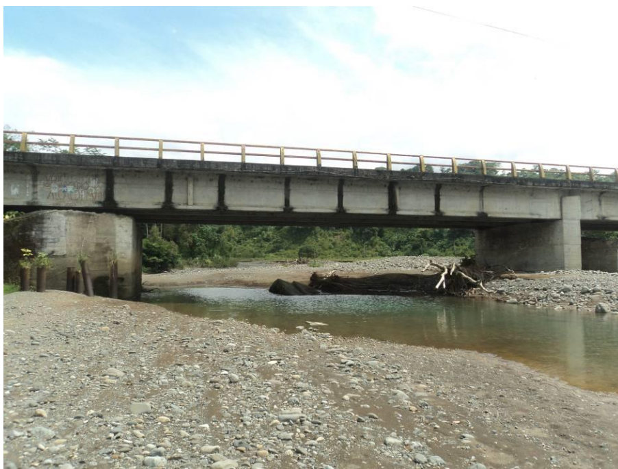
Fotografía 3. Zona de la concesión minera atravesada por el puente de la autopista Medellín Turbo (No. 62). Se pueden apreciar los depósitos de materiales en ambas columnas del puente.
