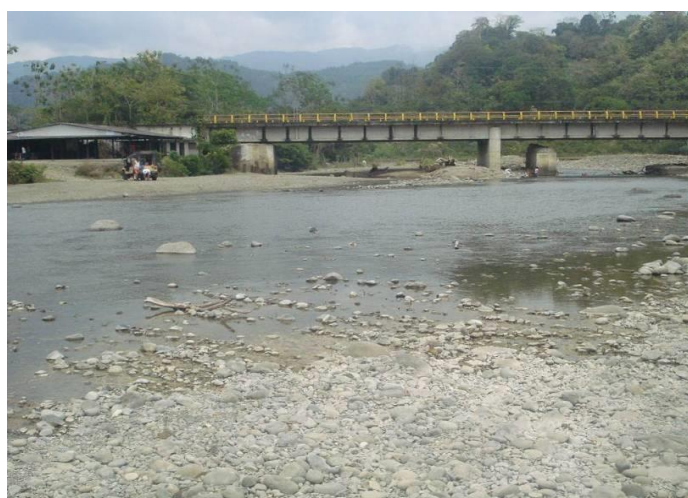
Fotografía 12. Bases del puente sobre el río La Fortuna.
