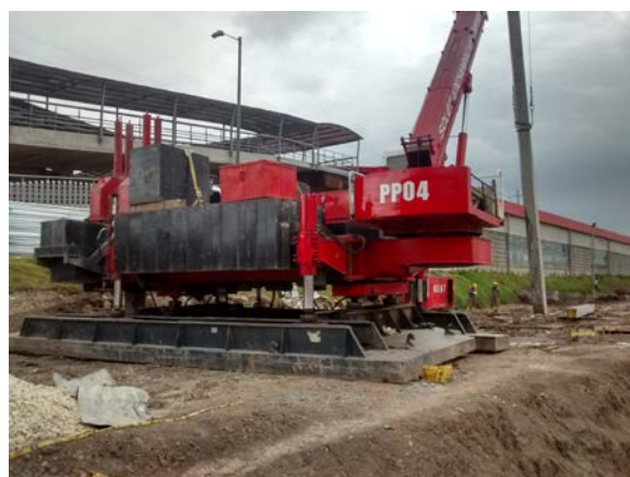
Foto 9 a 12. Disposición de maquinaria para la implementación de pilotes que operan como muros de contención permitiendo la excavación a la profundidad requerida para los 2 sótanos.
