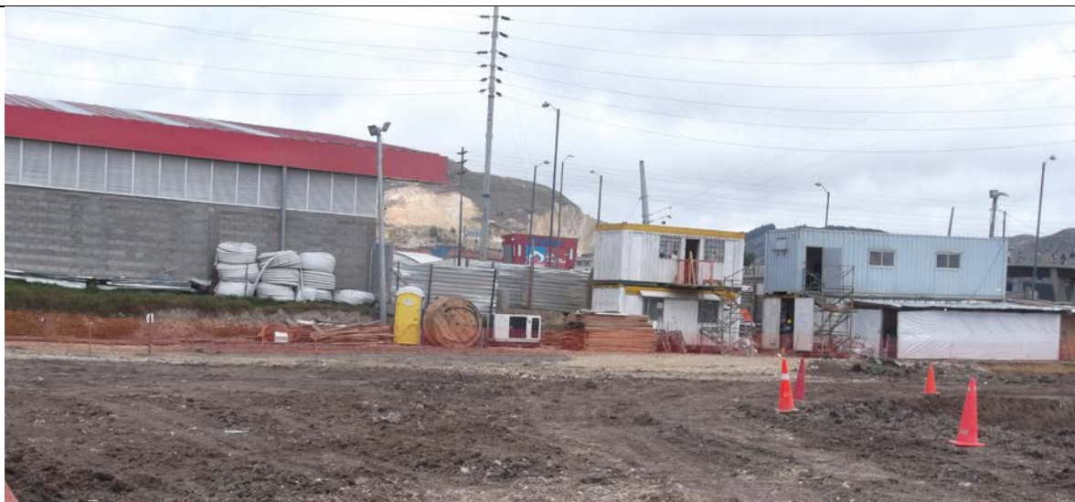
Foto 36: Panorámica de área sin intervención de obras civiles. Zona de Bulevar Centro Comercial Gran Plaza San Mateo.
