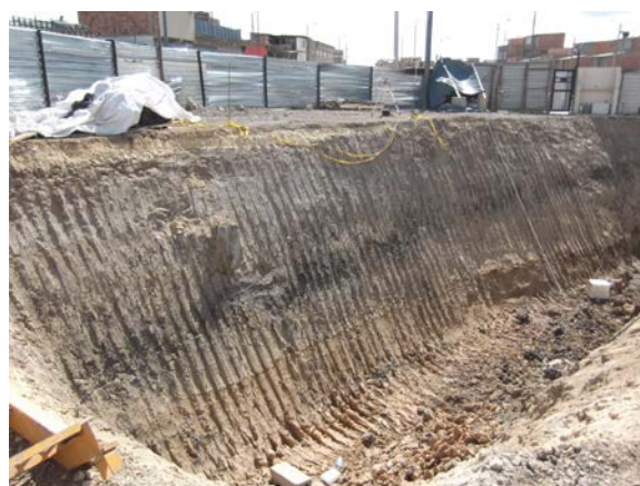
Foto 9 a 12. Disposición de maquinaria para la implementación de pilotes que operan como muros de contención permitiendo la excavación a la profundidad requerida para los 2 sótanos.
