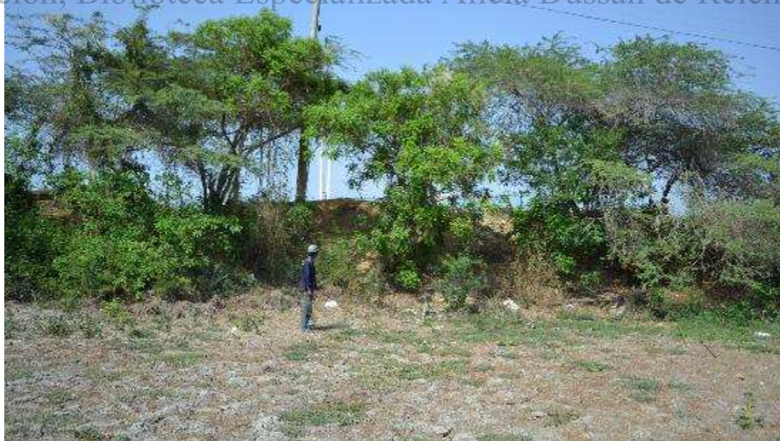
Fotografía 13. Vía de acceso al río Magdalena. Puede apreciarse la altura del relleno que fue utilizado para lograr la construcción de la vía a través de la cual se logra llegar al río Magdalena. De igual forma, se evidencia el lecho seco de las zonas de inundación.
