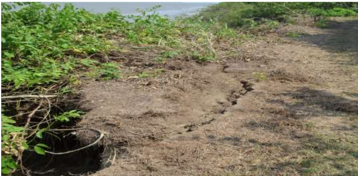
Fotografía 10. Inestabilidad del cauce del Magdalena, se aprecia el surgimiento de grietas en el suelo de hasta 1.5 mt de profundidad a través de las cuales va entrando el agua y finalmente colapsan bloques de suelo.
