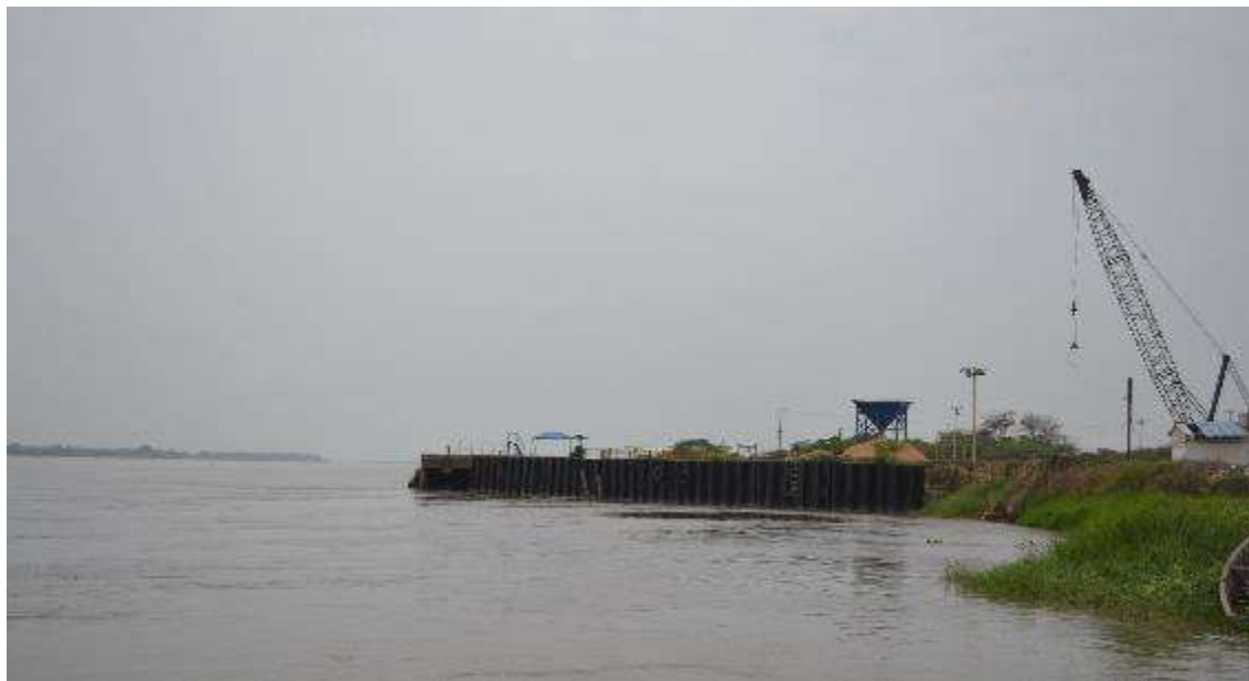
Fotografía 4. Jarillón construido para dar estabilidad al cauce del río Magdalena.
