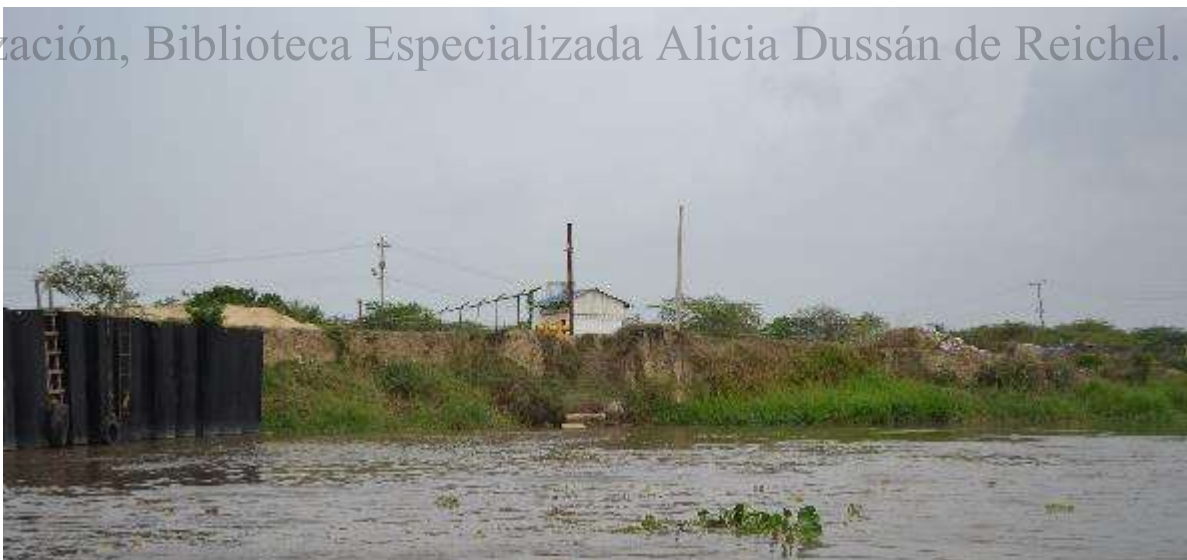
Fotografía 11. Jarillón y rellenos del área del puerto.
