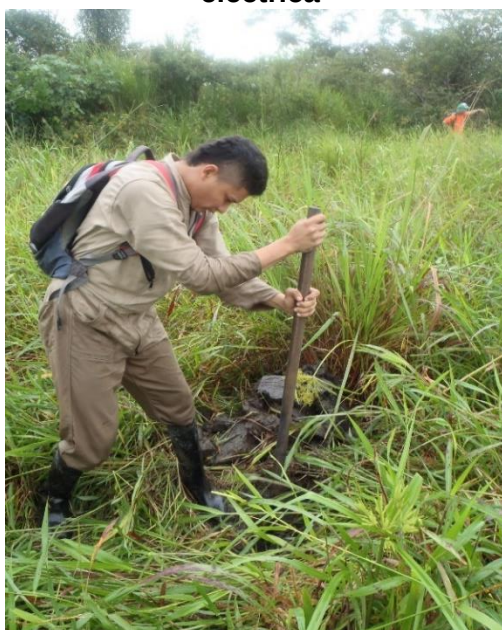
Fotografía 17 Realización de pozos de sondeo en el trazado d de la línea de flujo y línea eléctrica
