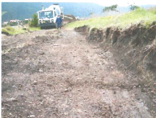
Foto 7. Camino de acceso intervenido
