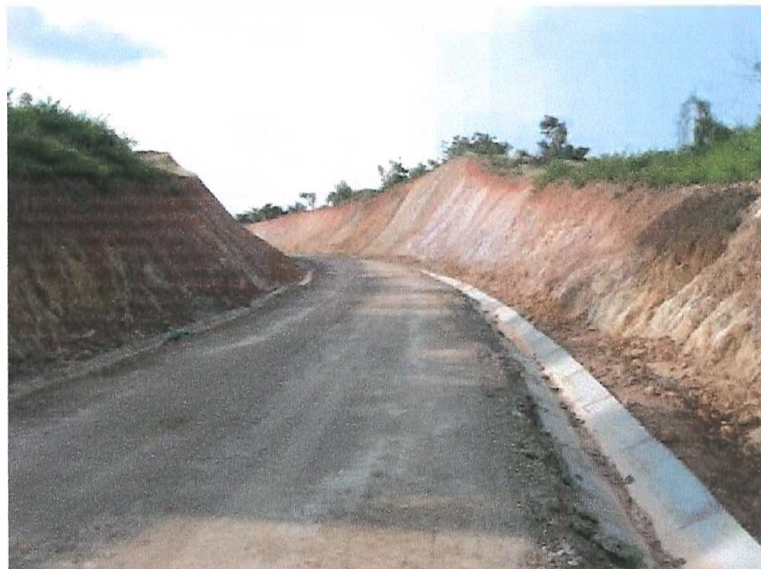
Foto 4. Taludes de la Banca en Paisaje de Sabana
