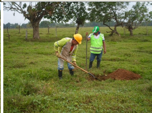
Fotos 21-24. Apertura de pozos de sondeo con suelos de grava y arena.
