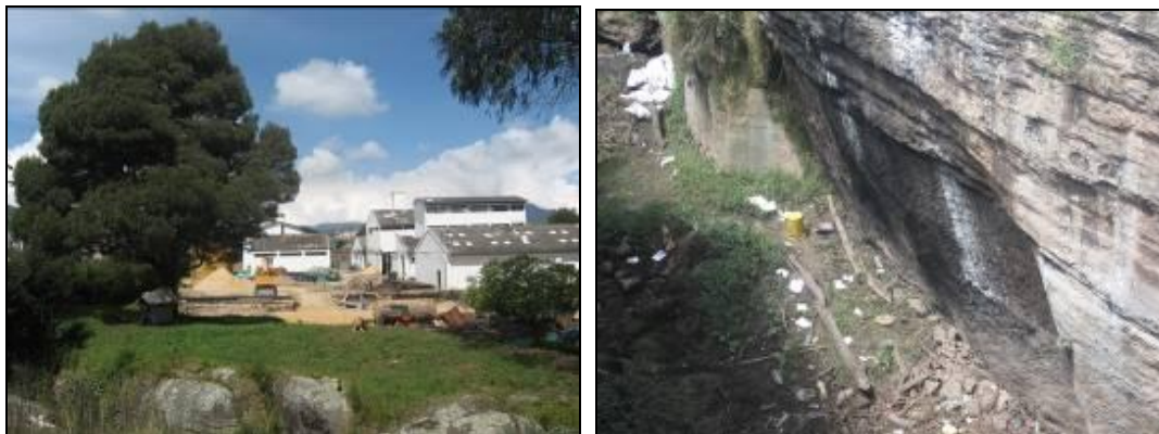
Fotografías 3 y 4. Terraza de mayor nivel del río y paredes de escarpes afectadas por fogatas
