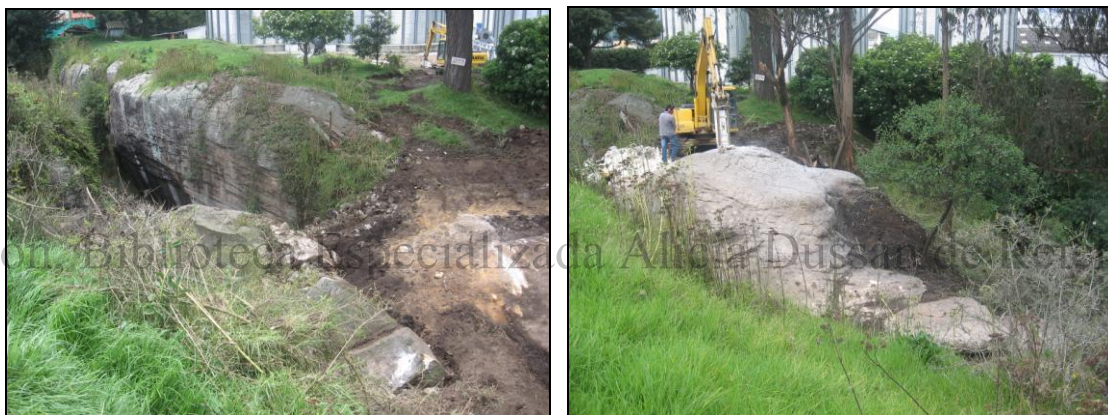
Fotografía 34 y 35. Secuencia del seguimiento a la perforación de las rocas
