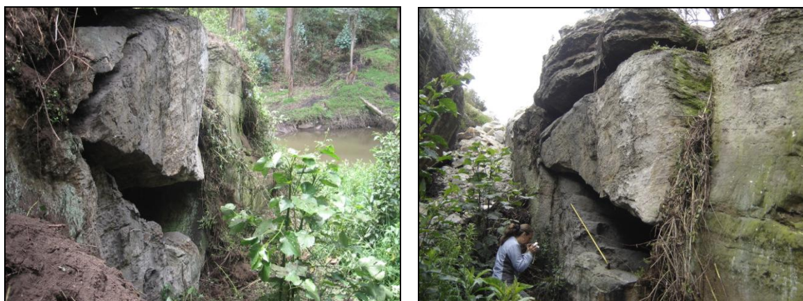
Fotografías 26 y 27. Secuencia revisión de perfiles del escarpe a intervenir
