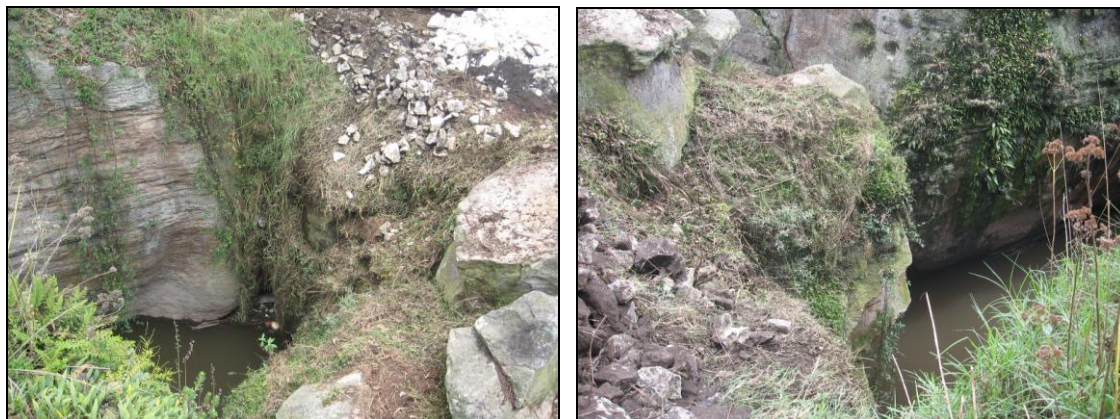
Fotografías 10 y 11. Dos ángulos del tapón sobre el río
