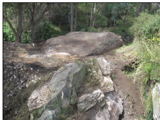
Fotografías 18 y 19. Rocas dinamitadas provenientes del escarpe
