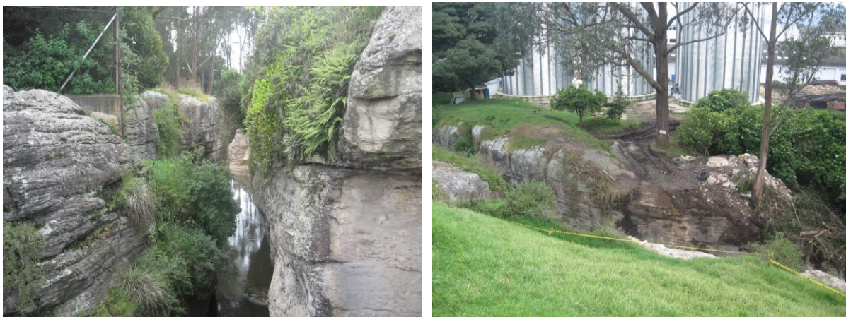
Fotografía 38 y 39. Finalización de las obras.
