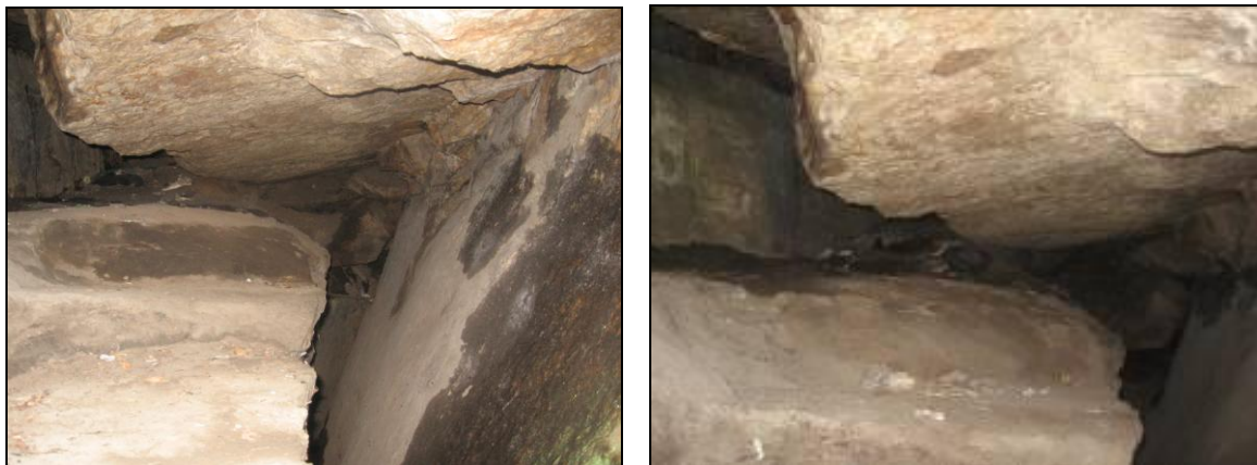
Fotografías 28 y 29. Interior de grieta formada por las rocas a manera de caverna
