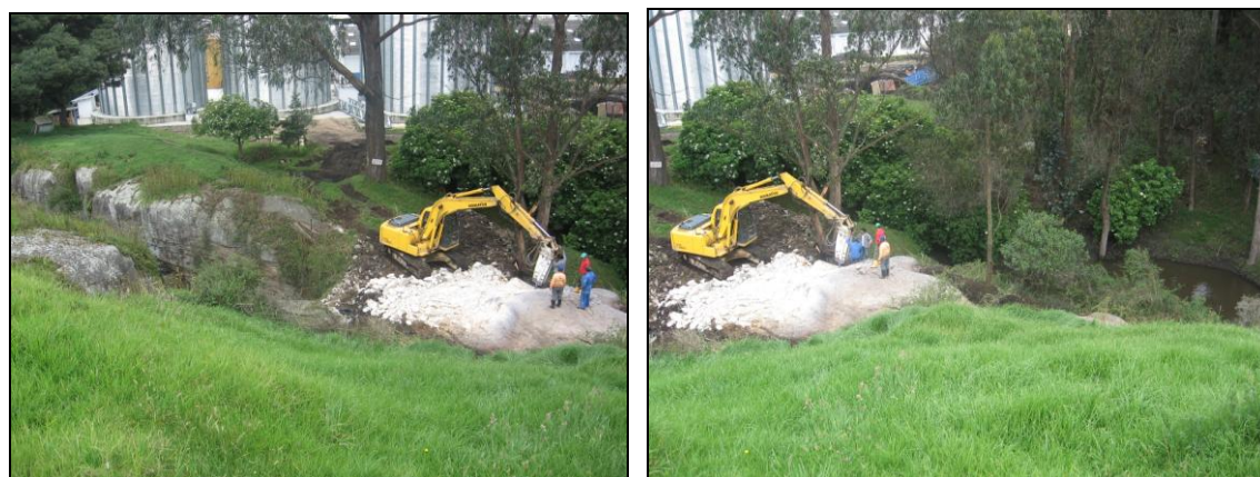
Fotografía 36 y 37. Secuencia del seguimiento a la perforación de las rocas
