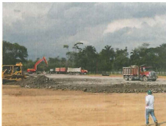
Fotografía 2 Levantamiento de Talud con material de descapote
