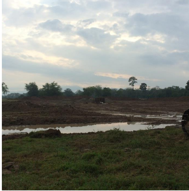
Foto 5. Proceso de encharcamiento del área descapotada antes del inicio de la fase de afirmación y aplanado del terreno
