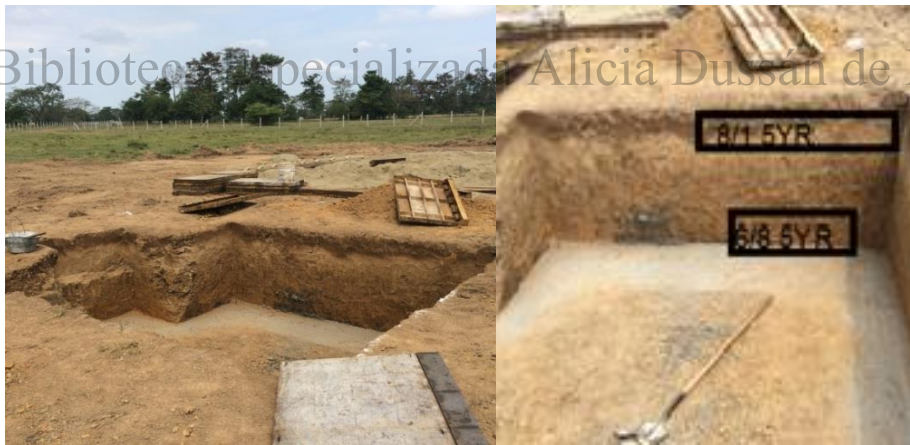
Fotos 3 y 4. Descapote y remoción del sector del contrapozo dentro de la plataforma del pozo Mochuelo 1.
