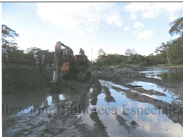
Foto 3 Extracción de material para construcción del puente (río Tucuy).
