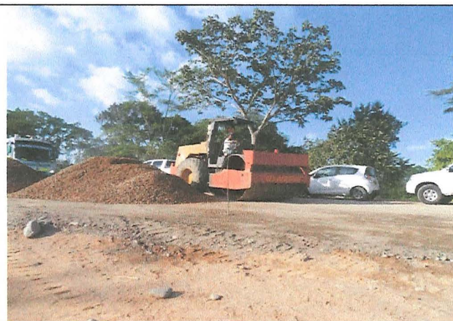
Foto 6 Adecuación de la vía ajustado al puente
