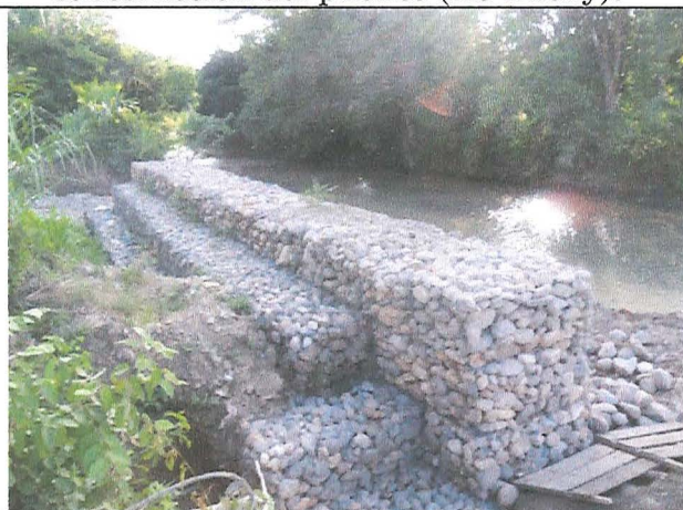
Foto 5 Muros de contención
