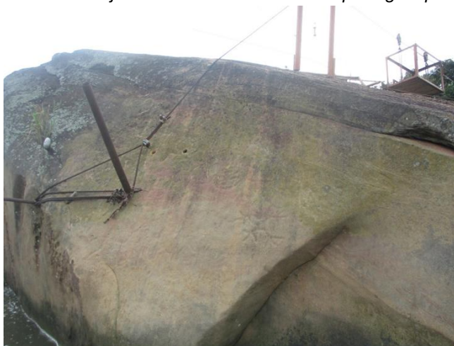
Fotografía 12. Anclajes metálicos en la roca del petroglifo para tarabita
