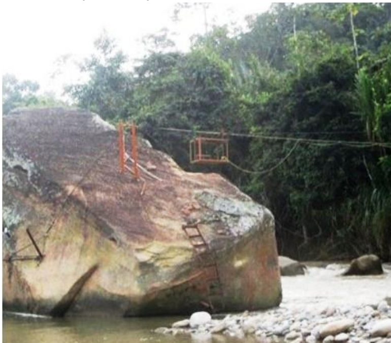
Fotografía 14. Andamiaje tarabita y escalera metálica anclada en la roca del petroglifo
