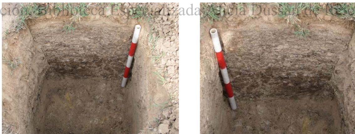
Fotografía 4.63. Sondeos realizados en la UIA-30.
