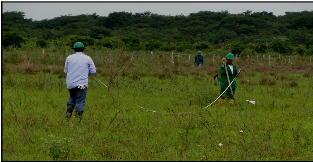
Foto N°5. Proceso de ubicación y elaboración de los pozos de sondeo.
