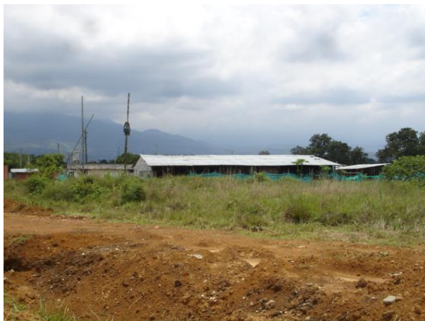
Foto 2. Campamento utilizado para bodegas y oficinas de la obra
