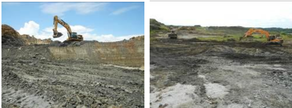
Foto 7 y 8. Seguimiento a las labores de ingeniería
