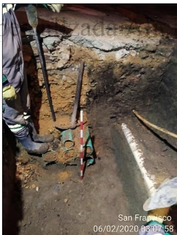
Fotografía 5-10. Actividades de excavación Nodo 3217
