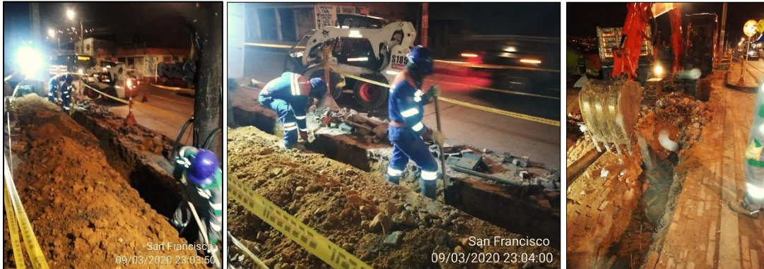
Fotografía 5-15. Excavación manual y mecánica zanja de tendido entre Nodos 3219 y 3220
