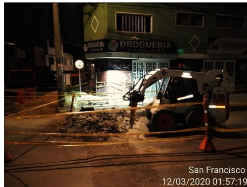
Fotografía 5-18. Excavación zanja de tendido entre los Nodos 3220 y 3705
