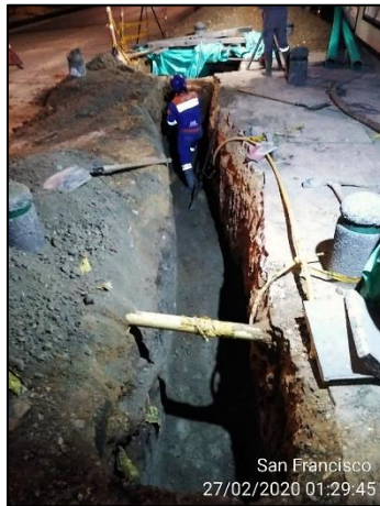
Fotografía 5-11. Actividades de excavación Zanja de tendido entre los Nodos 3217 y 3218
