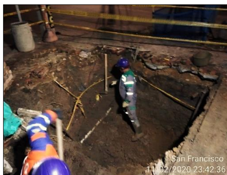
Fotografía 5-12. Actividades de excavación Nodo 3218
