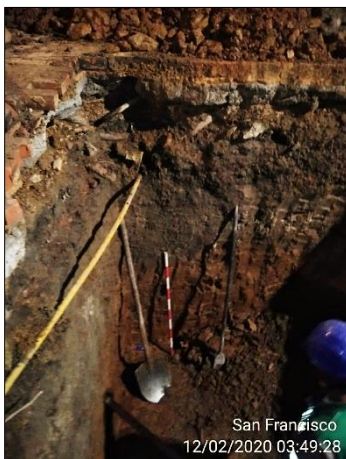
Fotografía 5-14. Actividades de excavación Nodo 3219
