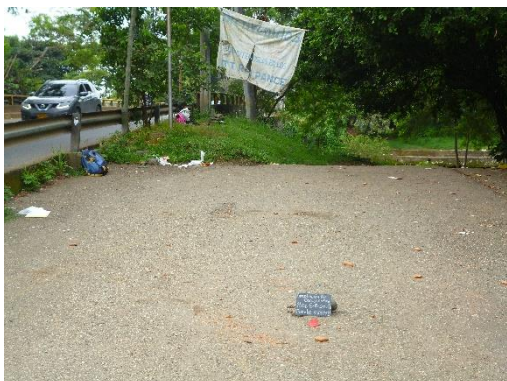
Foto 4. Descarte del sondeo 6 por presencia de placa de concreto
